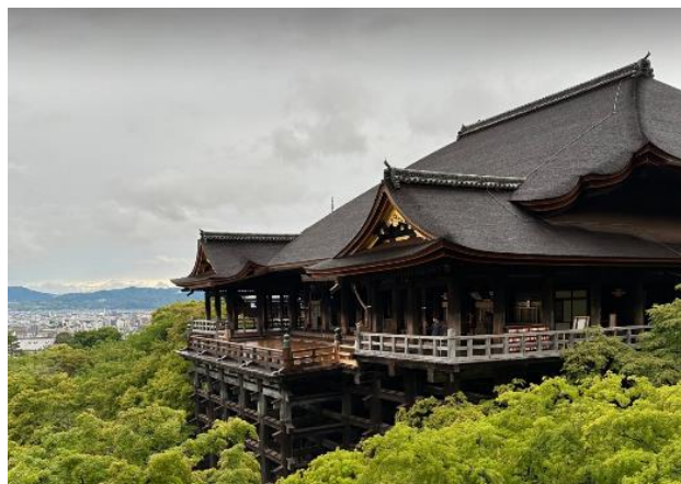
重新整修後檜皮屋頂與正殿
