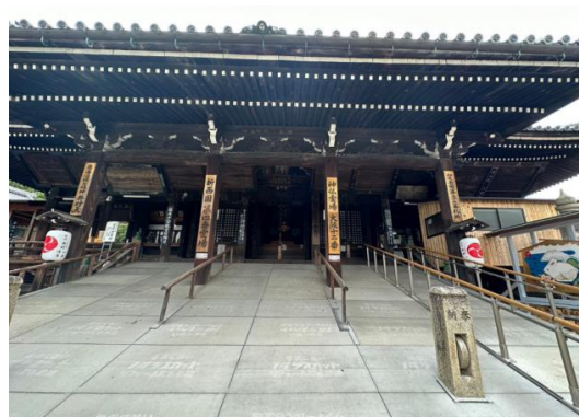
水間寺無障礙坡道
