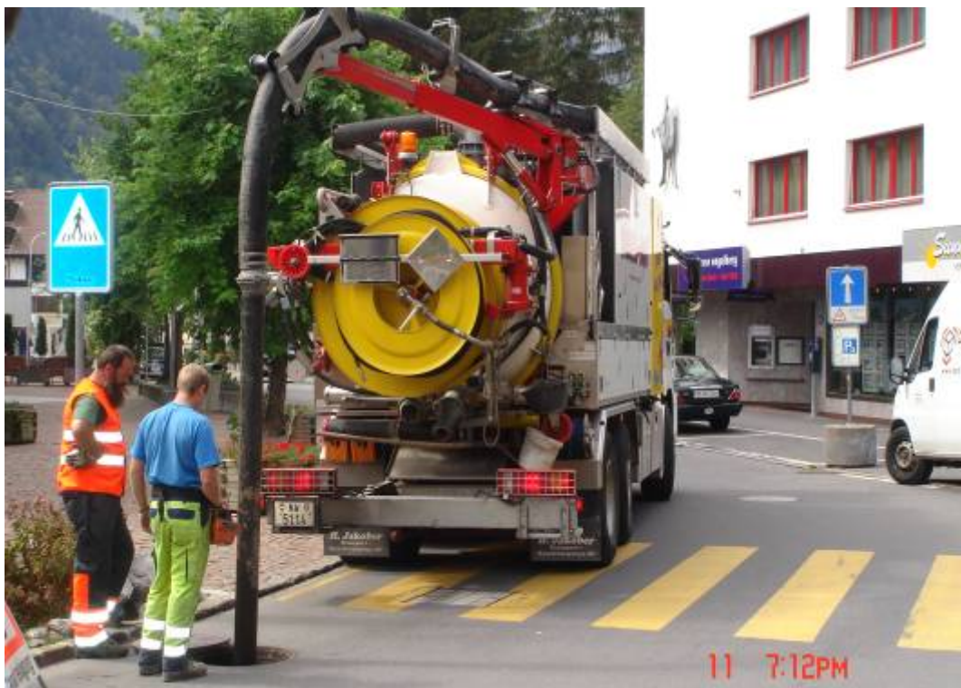
照片十五：便捷的除污車有效的清潔下水道污泥
