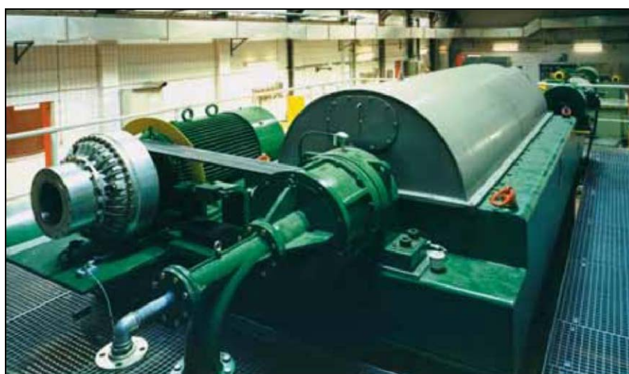
圖二、污泥脫水/離心分離器
