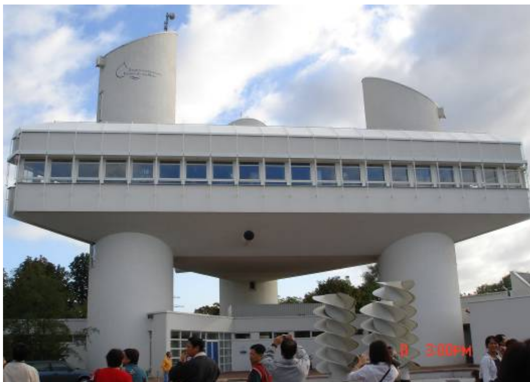
照片一：德國尼德拉德（Niederrad）污水處理廠外觀建築物
