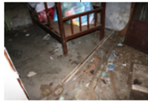
①②現場地坪各別分割為：水泥粉刷、抵石子、塑膠地磚三個區塊。
