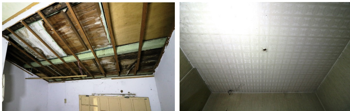
圖4-169 P棟9號緣側屋留存部分、11號室內木作天花板表面貼壁紙
