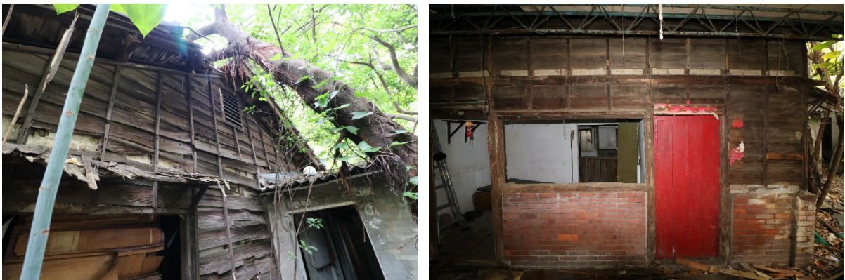
圖4-184 Q 棟 10-1 號山牆面通風口留存、10-1 號入口立面現況
