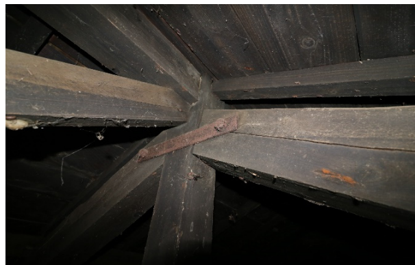
圖4-188 Q 棟屋架現況、合掌位置可見木料裂痕
