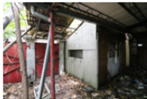
①⑦木作牆外側表面為石棉瓦浪板。
