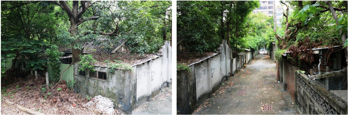
圖4-178 Q棟 10-1 號後院現況、10 號側院增建物外推現況
