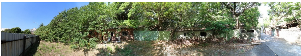
圖4-175 Q 棟鄰東南側圍牆與增建物
