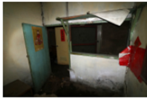
⑦室內僅部分牆體保留完整。
