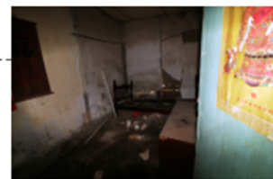
②舊有建物地板保留原有夯土地坪。
