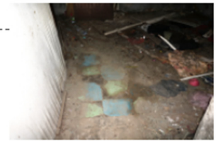
①①地板鋪面為塑膠地磚，表面髒汙，部分破損。
