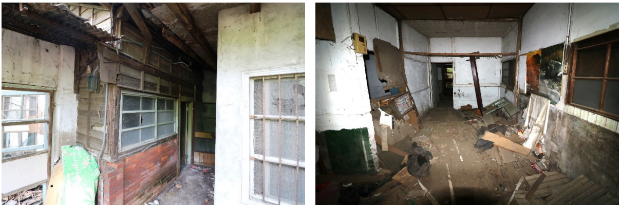
圖4-183 10 號外牆雨淋板、室內壁體現況
