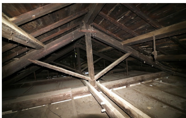
圖4-188 Q 棟屋架現況、合掌位置可見木料裂痕
