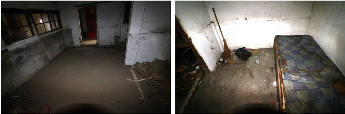
圖4-181 Q棟10-1號床架現已拆除、10-1號夯土地坪
