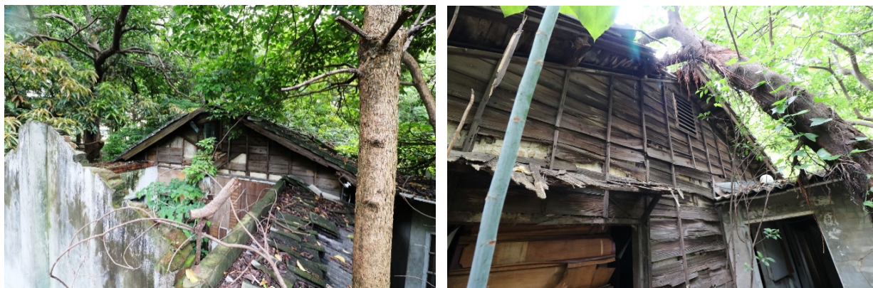
圖4-193 Q棟東北側山牆面與屋頂現況、西南側山牆面與屋頂現況
