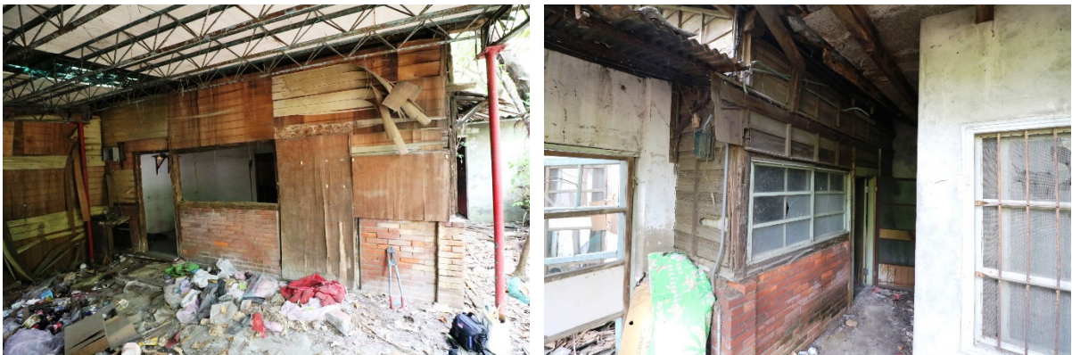
圖4-179 Q棟 10-1 號現已無通風口留存、10 號現已無通風口留存
