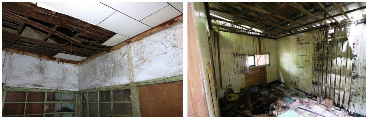
圖4-195 Q棟室內天花板現況、原天花板覆蓋裝修面板
