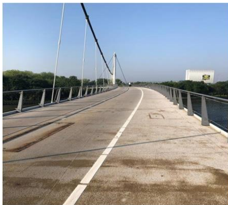
橋面欄杆採用不鏽鋼網
