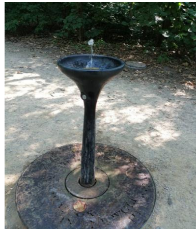
自來水生飲設備
