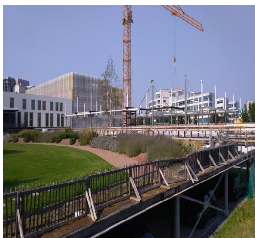
循環商業園區建築工程吊裝
