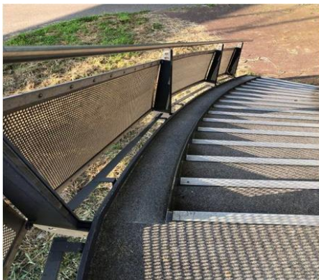
樓梯軌道供牽引自行車使用
