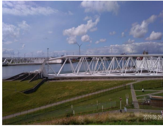
大壩巨型鋼桁架系統（二）
