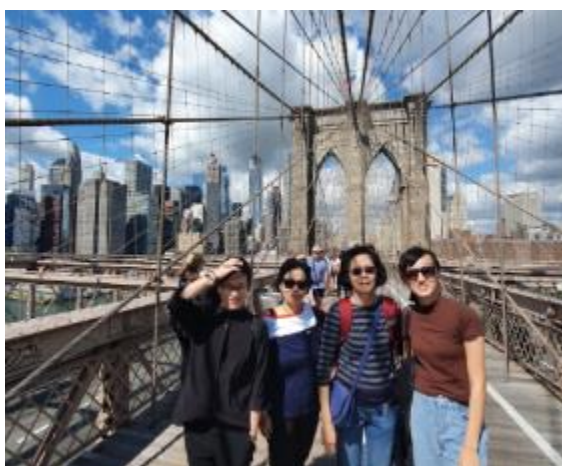
圖10 布魯克林大橋
