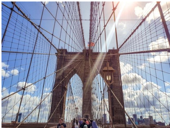
圖8 布魯克林大橋
