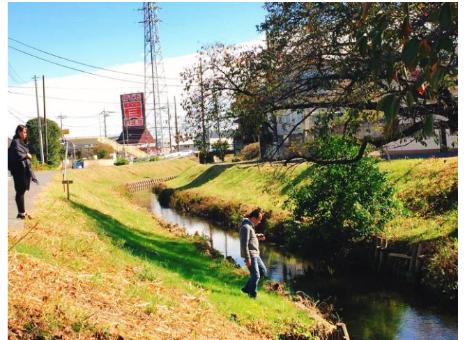
圖38. 兩側草坡，單層式木樁低水護岸
