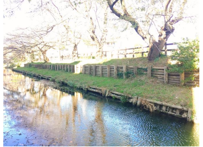
圖32. 雙層式木樁低水護岸
