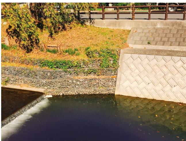
圖29. 石籠低水護岸
