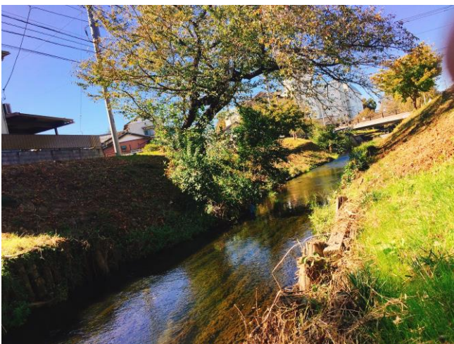
圖39. 兩側草坡，單層式木樁低水護岸
