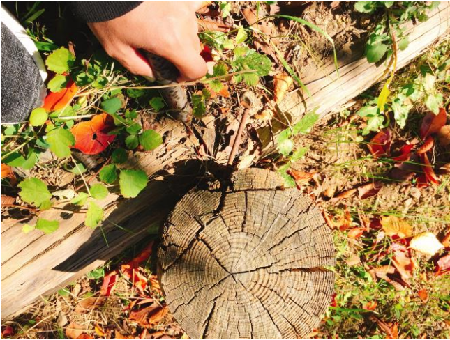
圖35. 木樁以一段約2米長方式搭接
