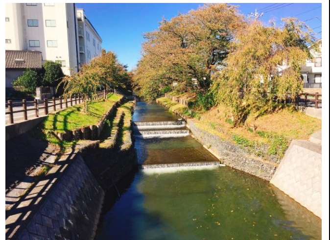
圖28. 宮下橋靠橋側為混凝土護岸
