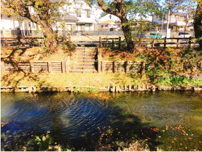
圖31. 雙層式木樁低水護岸
