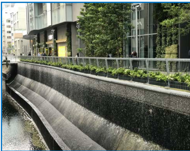
涉谷川護岸「壁泉」設施
