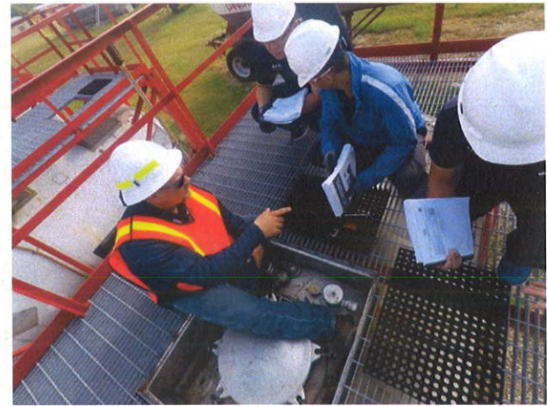
照片38：圖為 IMO fitting repair 操作流程，拆除螺絲後，換新破片即可。
