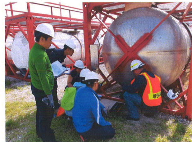
照片40：圖為 IMO external valve repair 操作流程，當有物質洩漏時，需正確更換墊片完成止漏。
