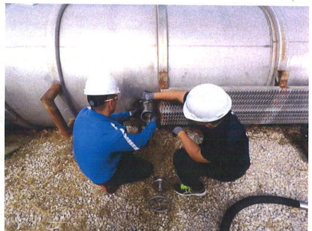
照片 34：圖為 cargo tank clean-out cap 操作流程，裝置 betts valve 進行安全移槽。
