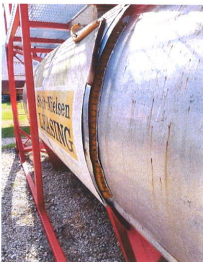
照片 45：圖為 IMO cladding (jacket)，保護其免於受到損傷、濕氣影響或內部物質污染。
