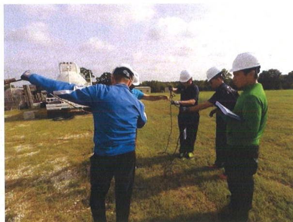
照片 28：圖為所有操作流程中必備流程， grounding and bonding(接地)程序能 降低操作的危險與意外。
