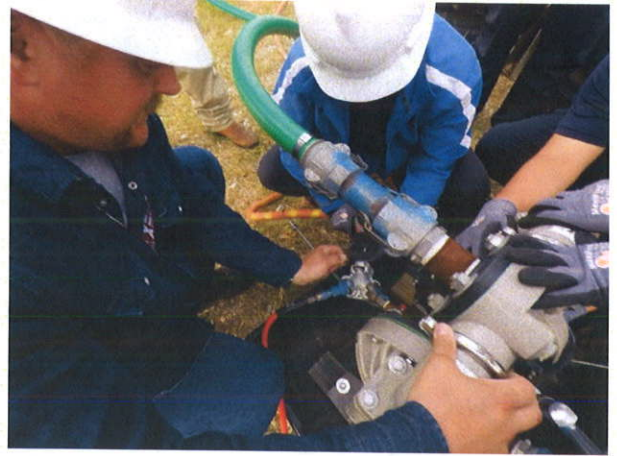
照片 30：圖為 cargo tank cold tapping 操作流程，幫浦連接兩槽車液體傳送管線，空壓機連接 drill(切割器)及加壓幫浦。
