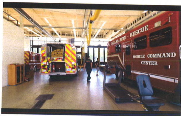
照片5：參訪達拉斯市一般分隊(station 6)，車庫有設置排氣系統，保持車庫空氣清淨。
