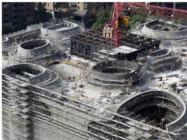
曲牆最大的特色，即是建築體全由曲牆單位構成，無任何樑柱支撐，且每個曲牆單位依位置的不同，所承載力道的不同，厚度為 40 cm~80 cm 的漸變；因此需要經過非常精密的計算，方可達到施工結構的最佳化尺及最佳的安全係數。
