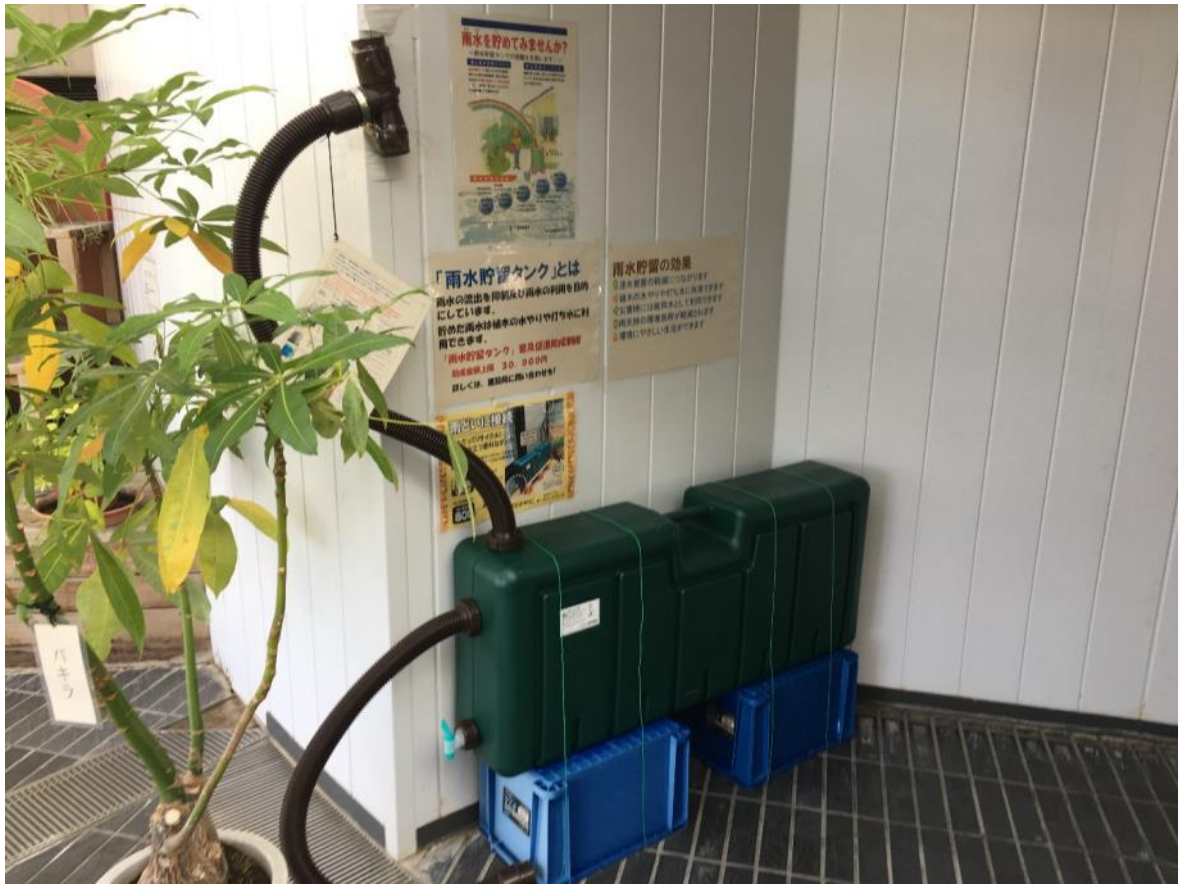
雨水貯留施設
