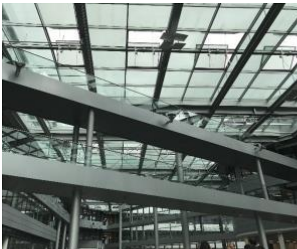
德國飛利浦大樓運用天窗採光及利用反射板將光源折射節約能源（二）
