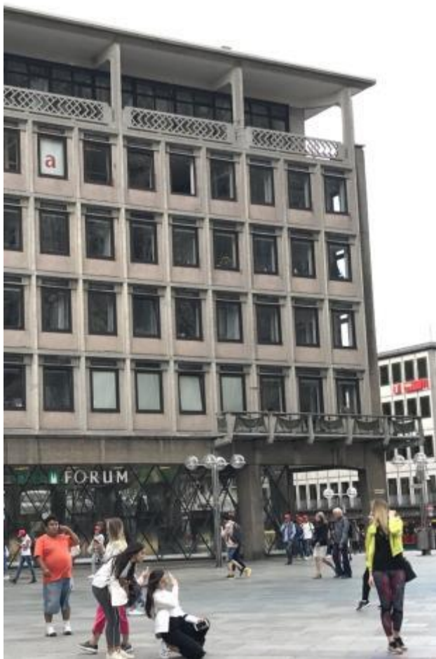
路燈照明未開啓時相片
