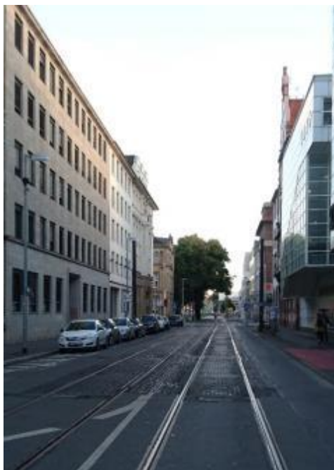
漢諾威街道路面養護情形
