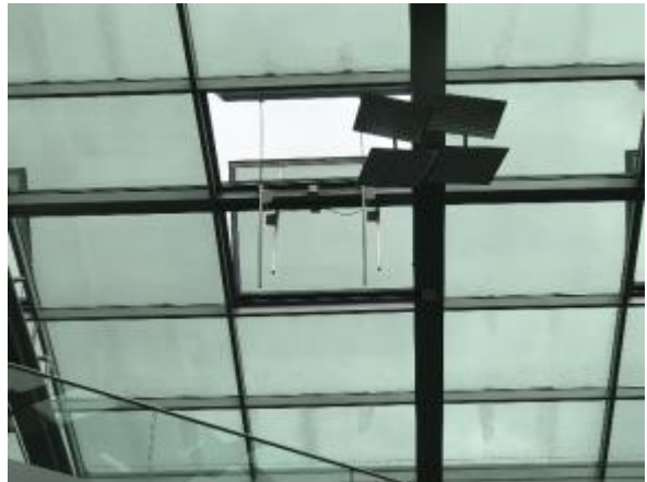
德國飛利浦大樓運用天窗採光及利用反射板將光源折射節約能源（一）
