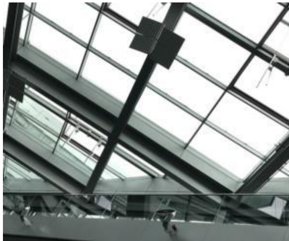
德國飛利浦大樓運用天窗採光及利用反射板將光源折射節約能源（二）
