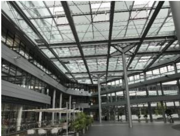
德國飛利浦大樓運用天窗採光及利用反射板將光源折射節約能源（一）
