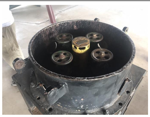
照片36：圖為SPANCER教官示範壓力槽車(鐵路運輸用)頂部容器閥如洩漏時，如何利用專用止漏器具(KIT C)進行止漏作業。
