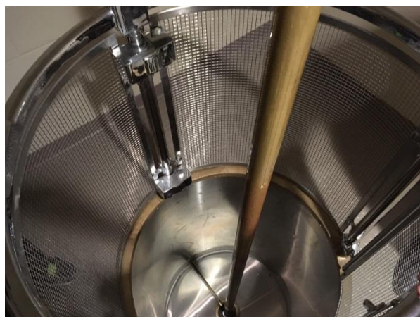
照片16：圖為本局受訓人員參訪當地消防隊，其所設置之緊急滑桿，其具備自動防止掉落設計，值得本局未來廳舍規畫設計參考。
