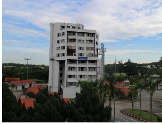
圖 11. 室內綜合模擬訓練大樓 (Furance) 外觀
