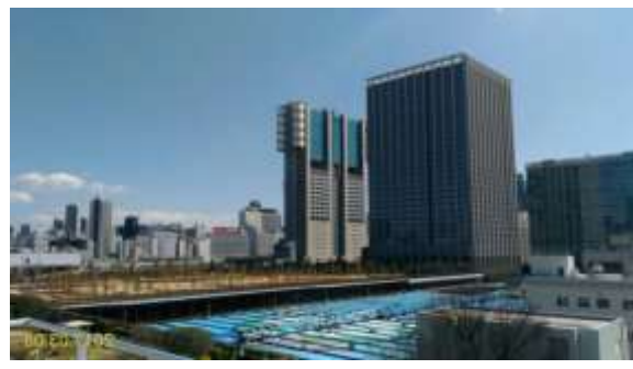
污水廠上部公園
