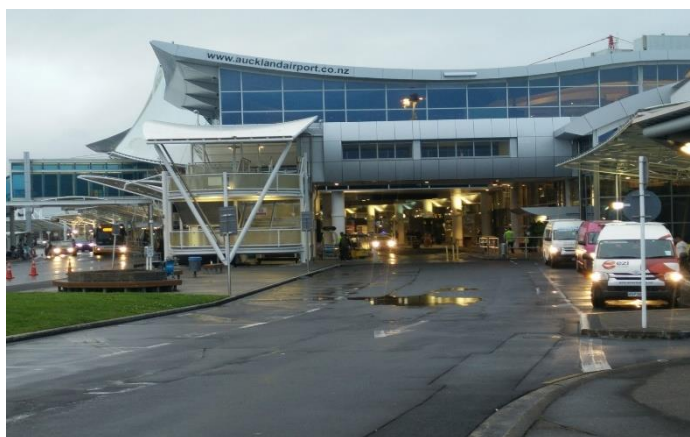
圖 4-2: 奧克蘭機場外圍，仍然感覺天氣相當寒冷
