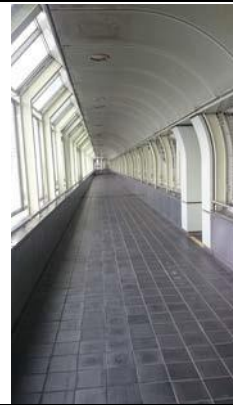
圖 6、明石大橋內廊道
