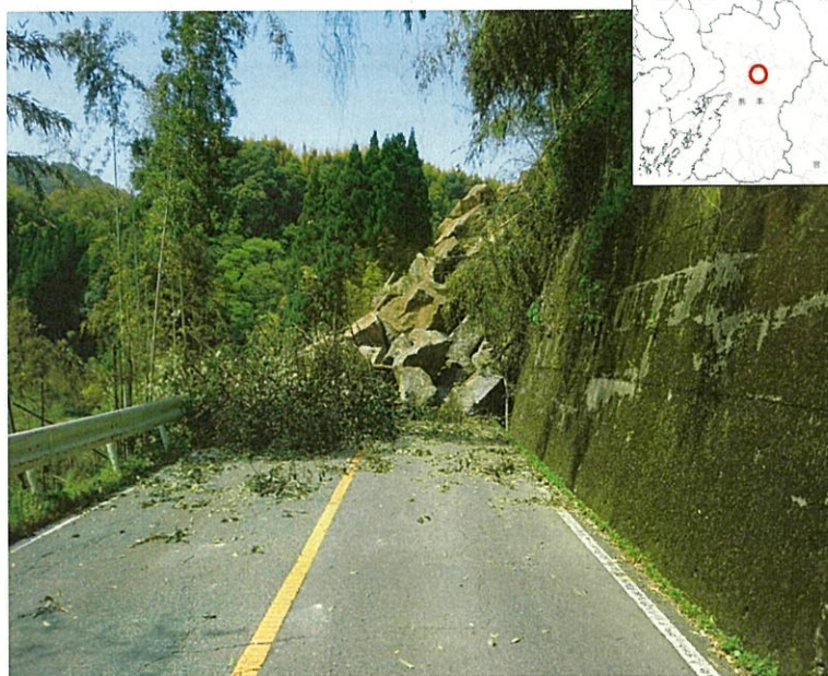
国道445号(御船町)
