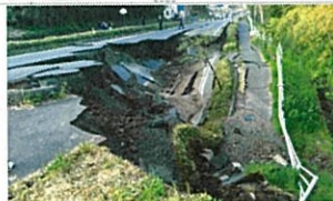
国道443号(益城町)路面陥没
