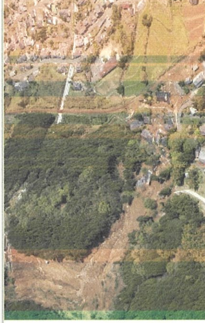
被災状況（平成28年4月16日撮影）
