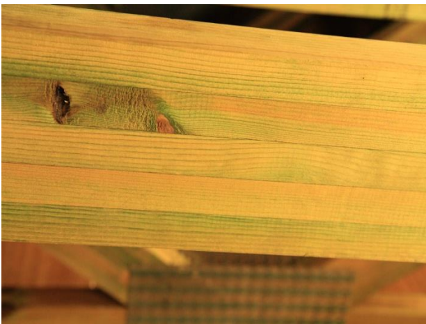
場地支撐結構體木條採合釘組裝方式，呈現綠色部分係因浸泡消毒所致
