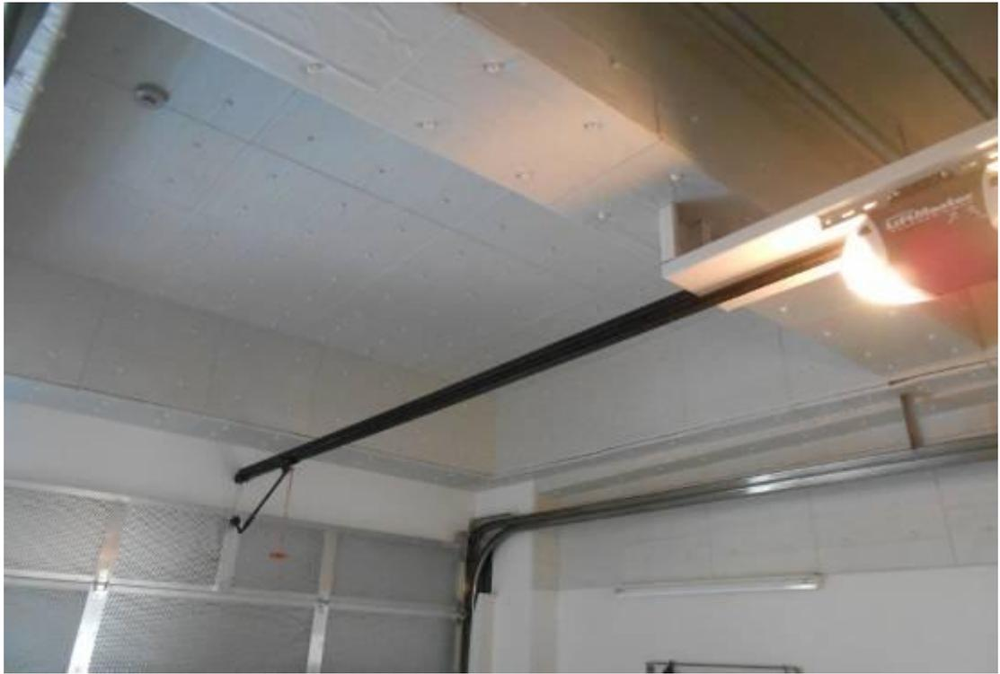
圖 79 橫濱市愛護動物中心流浪犬貓點交區屋頂有鋪設防火隔音泡棉，減少犬貓點交作業時所產生的噪音量
