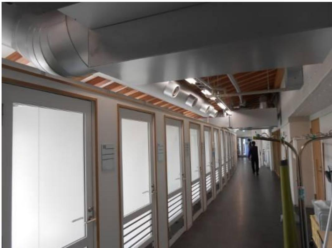
圖 98 橫濱市愛護動物中心犬收容棟位於地下 1 樓，全區終年保持恆溫攝氏 25-26 度，中央空調，每間犬舍有獨立空氣抽換裝置，屋頂裝有防火隔音泡棉，採單隻獨籠飼養方式，26 間籠舍，採光良好，走道空間寬敞
