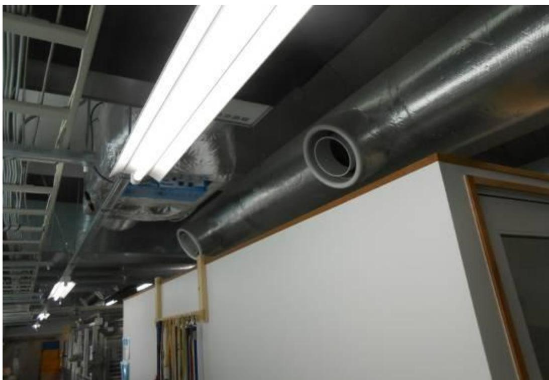
圖 94 橫濱市愛護動物中心犬隻隔離觀察室，配有中央空調系統，全年保持恆溫及定時抽換氣（一分鐘換氣 15 次），隔離室空氣品質良好無臭味
