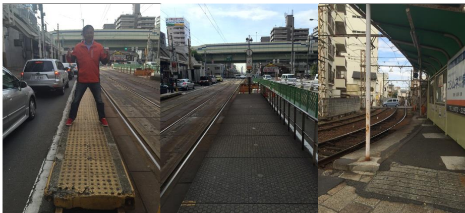
▲月台寬度：寬度具彈性化，可依現有道路寬道、線型及旅運需求進行調整，小則 1 公尺，大則約 2.5 公尺。
