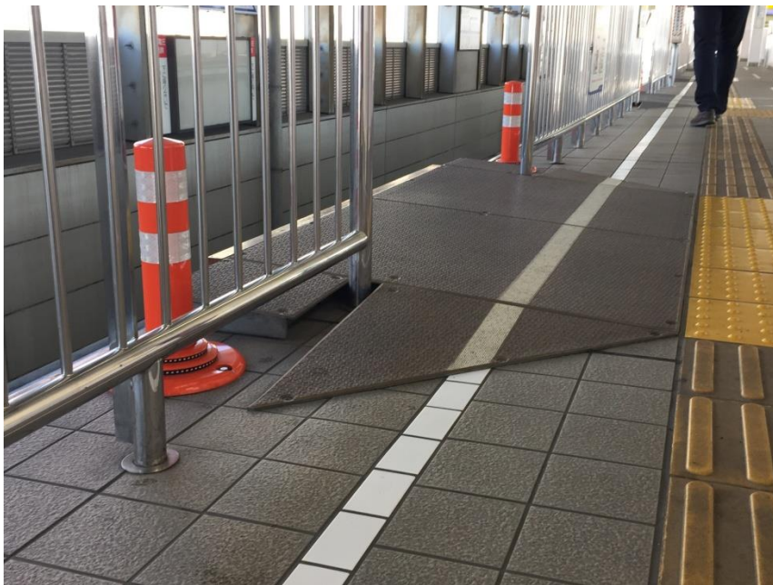
▲無障礙空間設計：設計斜坡道，月台高度與車門踏板高度相符，確保搭乘者之安全與便利。
