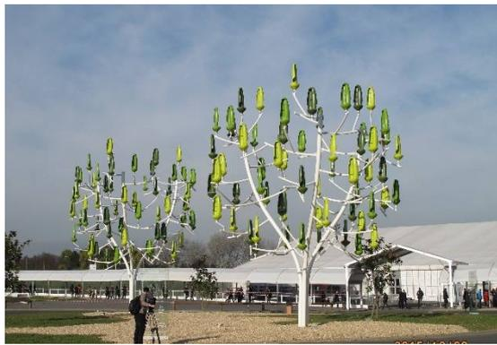
圖 9、矗立於大會入口處的風力樹，63 片葉子可產生 4.1kw 電力，年發電量 2400kw
