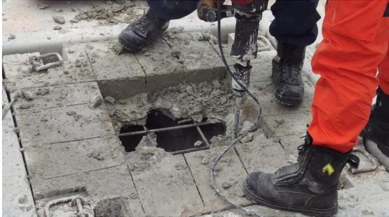
4. 將鋼筋剪斷後即可進入將患者救出，被剪斷的鋼筋十分鋒利必須小心。
