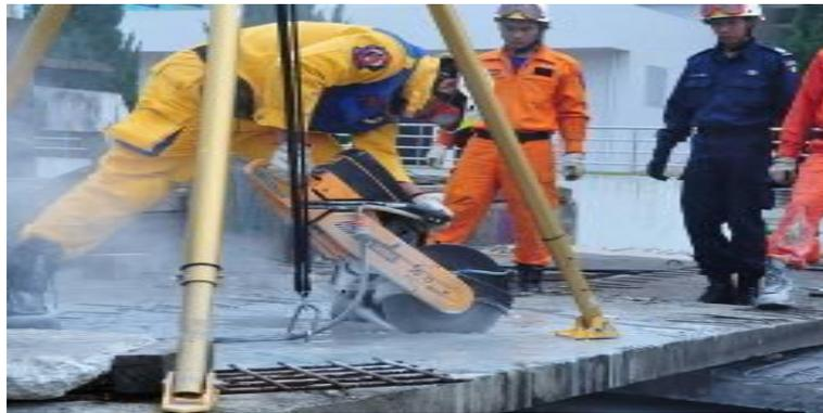
2. 切割完畢後可利用連接的繩索搭配省力滑輪組移除水泥塊。
