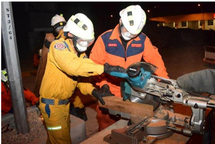
3. 測量組得到數據以後立即退出不穩固的建築物外，根據所得數據計算所需木頭尺寸、數量及角度。
