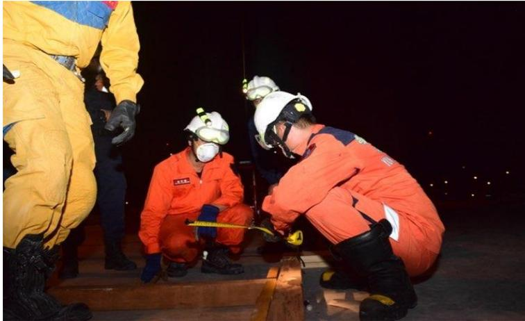
5. 確認無誤後先將能安裝的元件如夾板、止擋安裝上，這個動作的必要性在於壓縮待在不穩固建築物內的時間。
