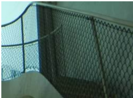
照 8 樓梯鋼絲網
