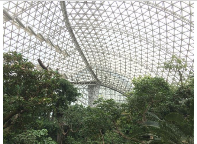
植物館－外形樹葉形狀，骨架配置仿照樹葉脈絡（2）
