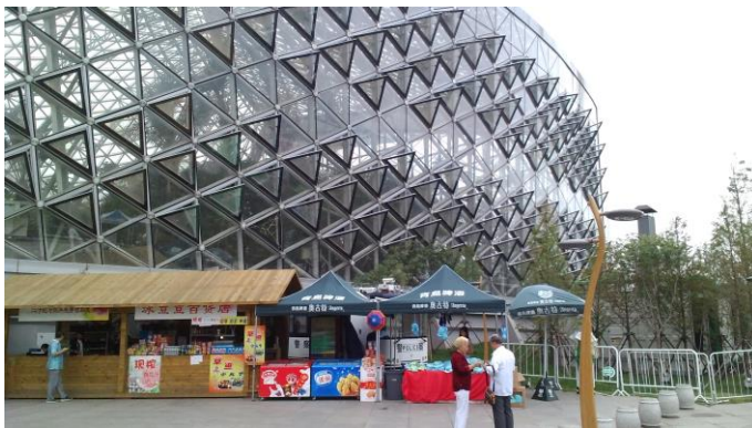
植物館－外形樹葉形狀，骨架配置仿照樹葉脈絡（1）
