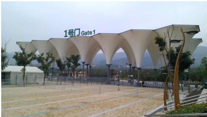
世園會園區出入口（1）
