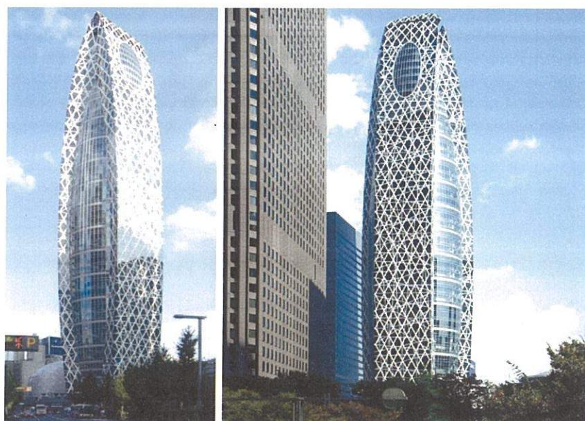
(2)外部結構共分三個方向弧狀交錯構架寬 24 公尺。內部核心為樑柱鋼構系統。
