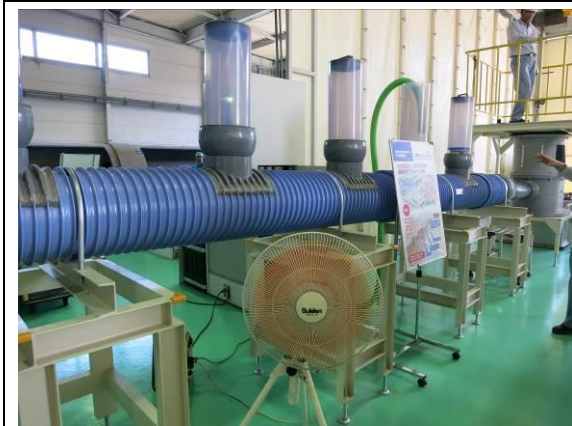
展示緊急災變時臨時廁所之污水管設置情形，可利用後端人孔開關控制，將存放於管內污物，一次吸引至後端人孔處
