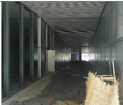
主展館外部均有玻璃帷幕包覆
