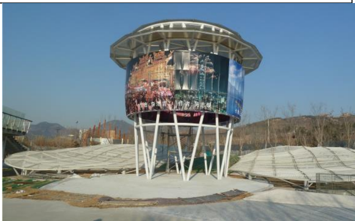
戶外展區之臺灣館已接近完工
