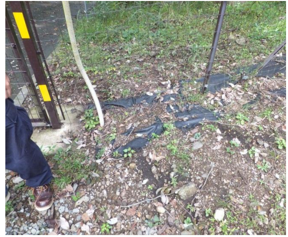
政府公設電器柵欄鐵網埋入地下防止猴子動物等鑽入
