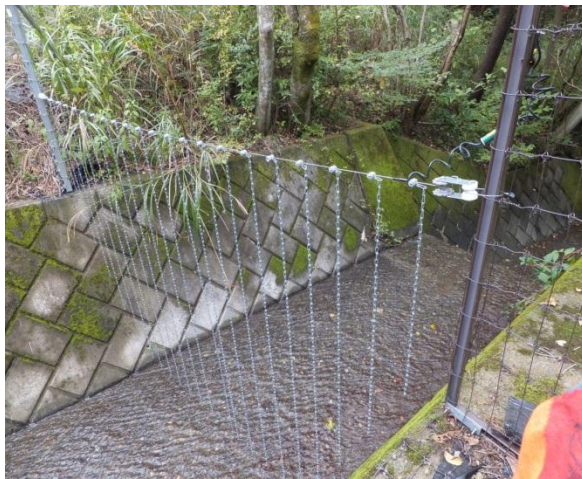
政府公設電器柵欄經過水溝設施鐵鍊碰到水時會自動斷電
