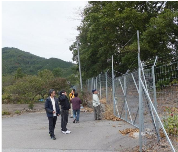
從大排水溝邊參觀公設失敗電器柵欄，電線沒有管理彎下漏電
