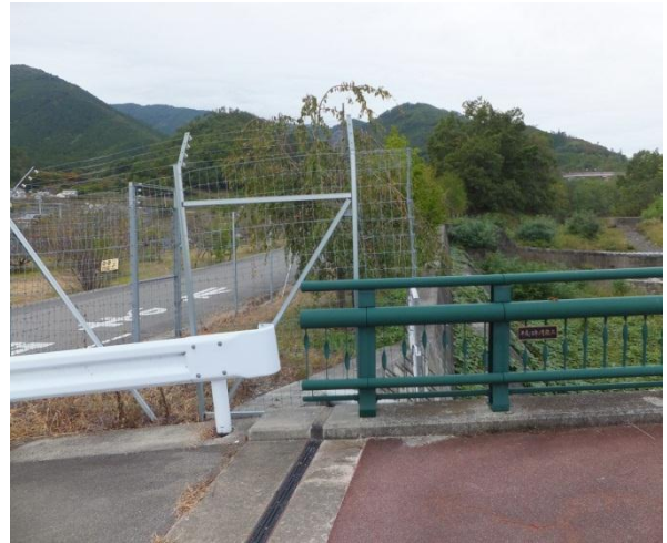
參觀公設失敗電器柵欄，因會從大排水溝床穿過橋爬上來危害農作物
