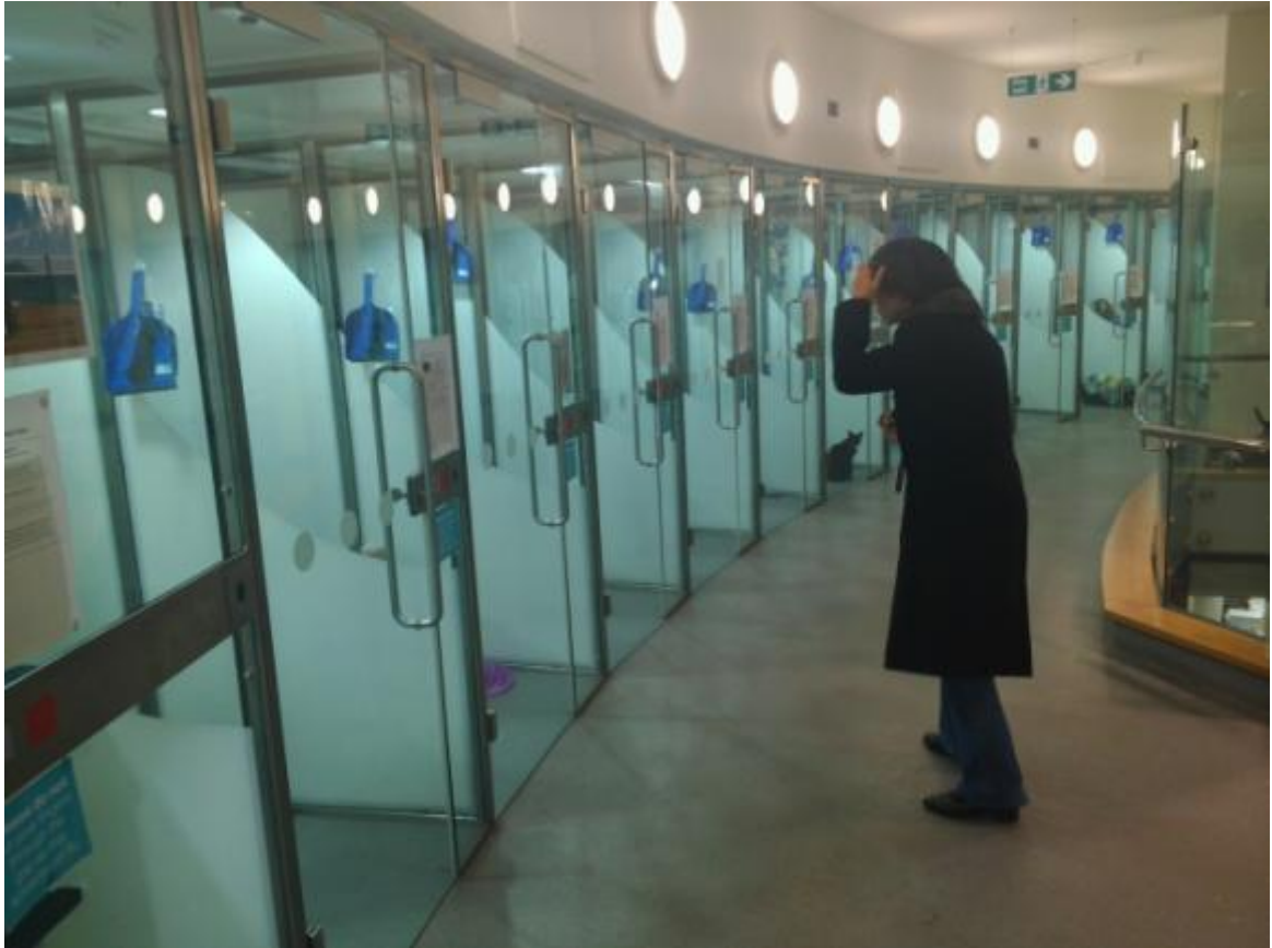
照片 24.貓屋設計全玻璃，對外透明隔間採霧面，減少貓咪緊迫
