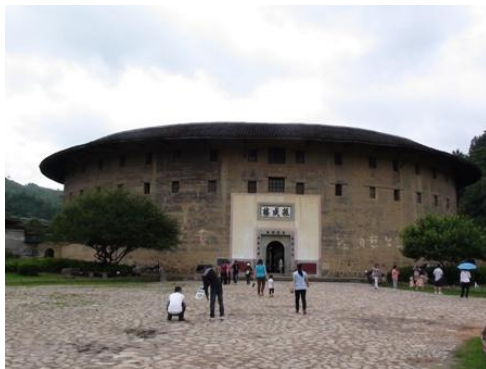
永定縣土樓振成樓參訪
