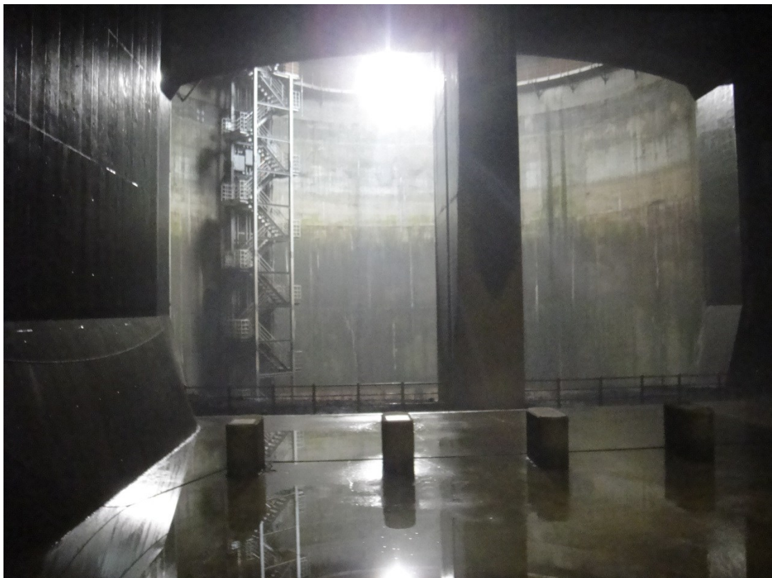
第 1 立坑與排水機場銜接處
