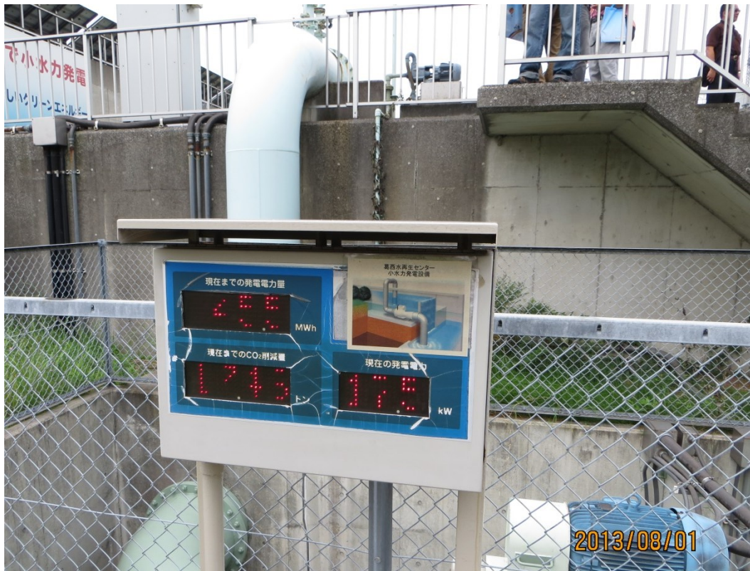
小型水力発電施設発電量顯示板
