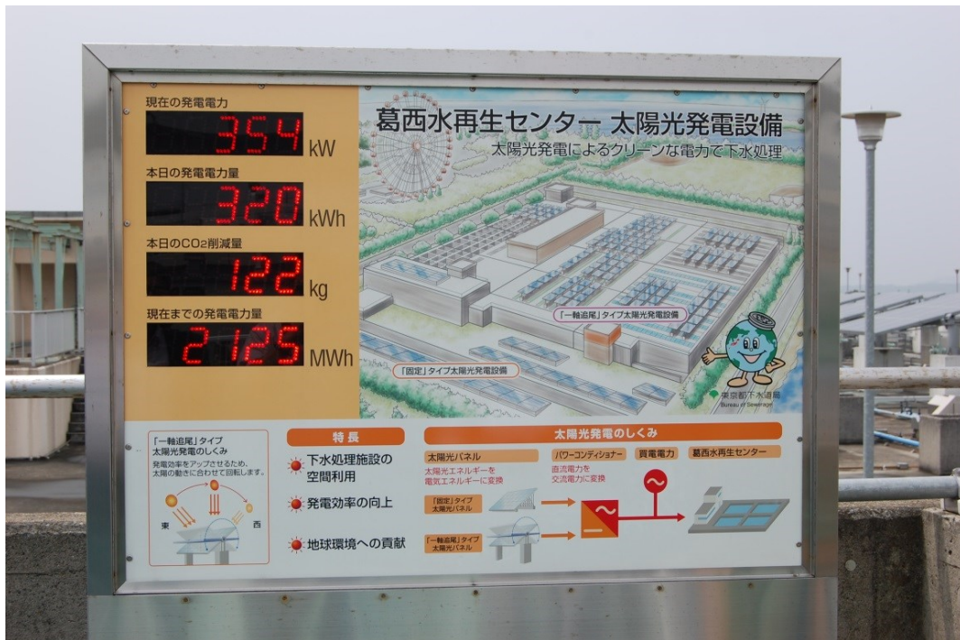
太陽能発電施設発電量顯示板
