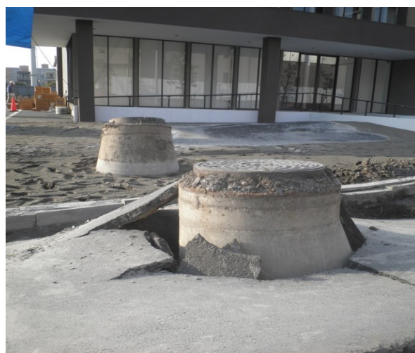
東日本大震災埋地土壤液状化現象新浦安 站人孔突出地面
