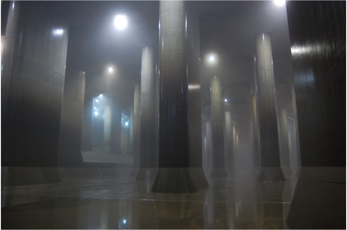
剛蓄過水的地下龍宮很壯觀但濕氣很重
