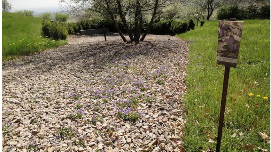
景觀鋪面儘量以透水工法處理，非不得已不用水泥
