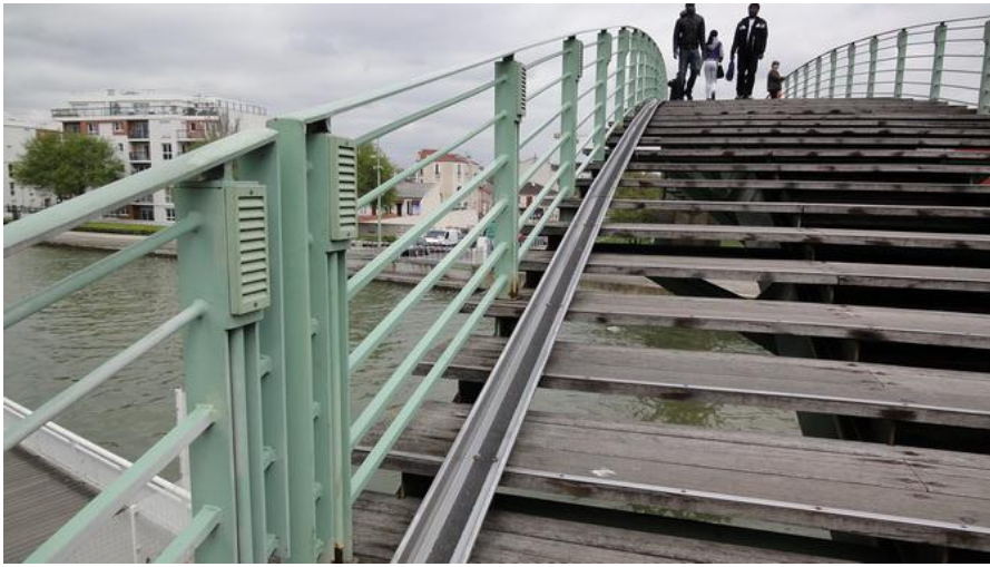
運河跨橋為自行車考量的輪胎邊溝設計
