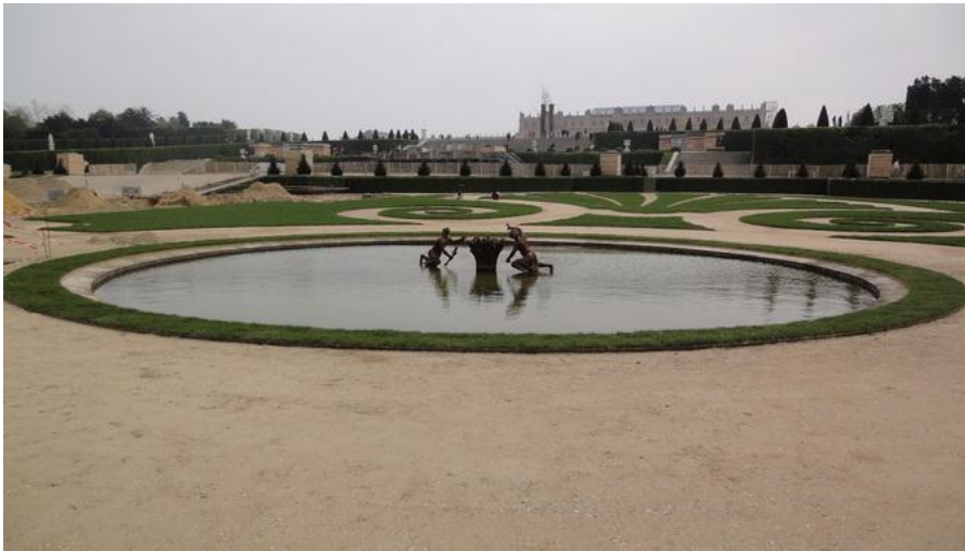
凡爾賽宮花園水池復舊改善工程
