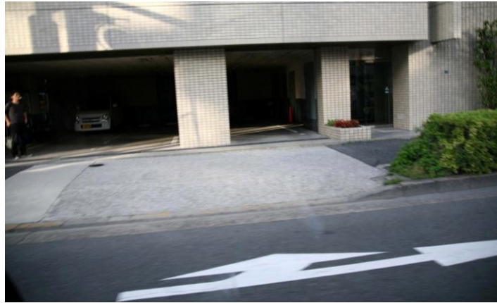
圖2.13 東京都人行道設置之車出入口斜坡道
