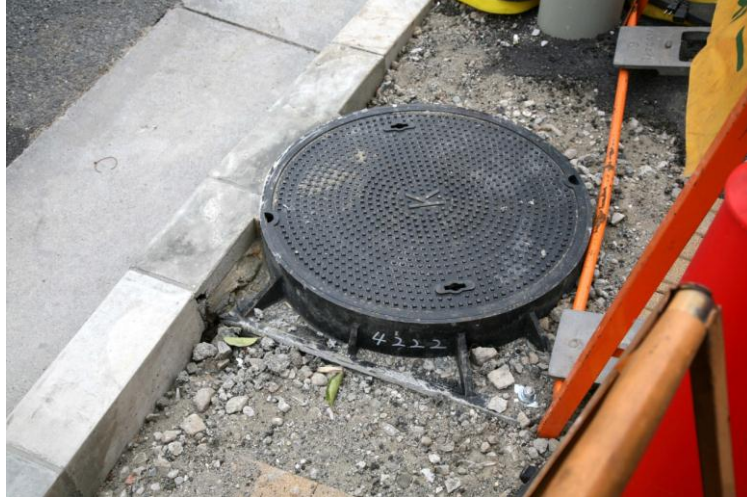
圖2.30人行道上人孔施工情形
