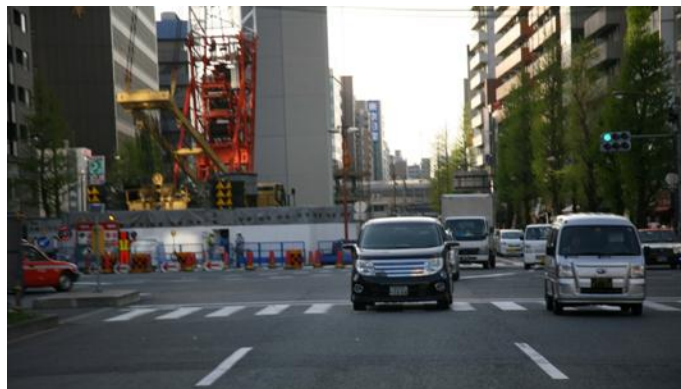
圖2.10 東京都道路施工
