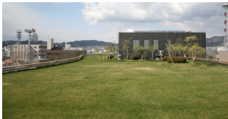
圖2.48 頂樓的空中綠化景觀頂樓的空中綠化景觀
