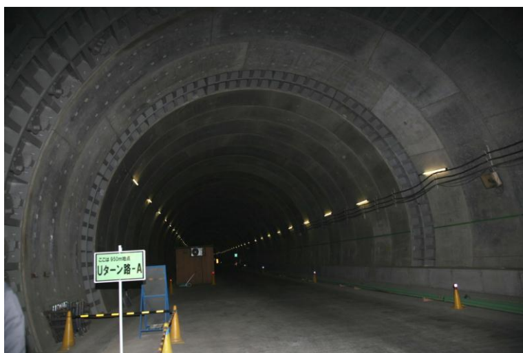
圖2.5 京都中央環狀品川線高速公路隧道工程外觀
