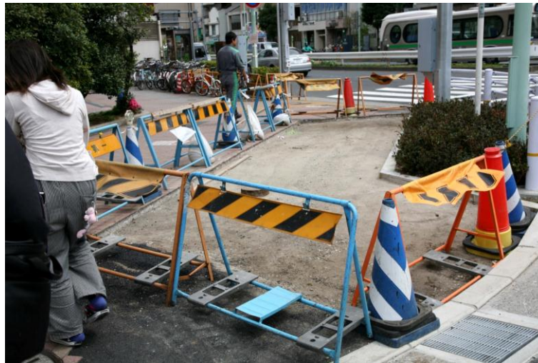
圖2.31人行道上人孔施工現場
