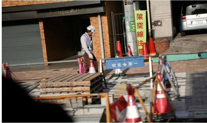
圖2.8 東京都人行道施工情形
