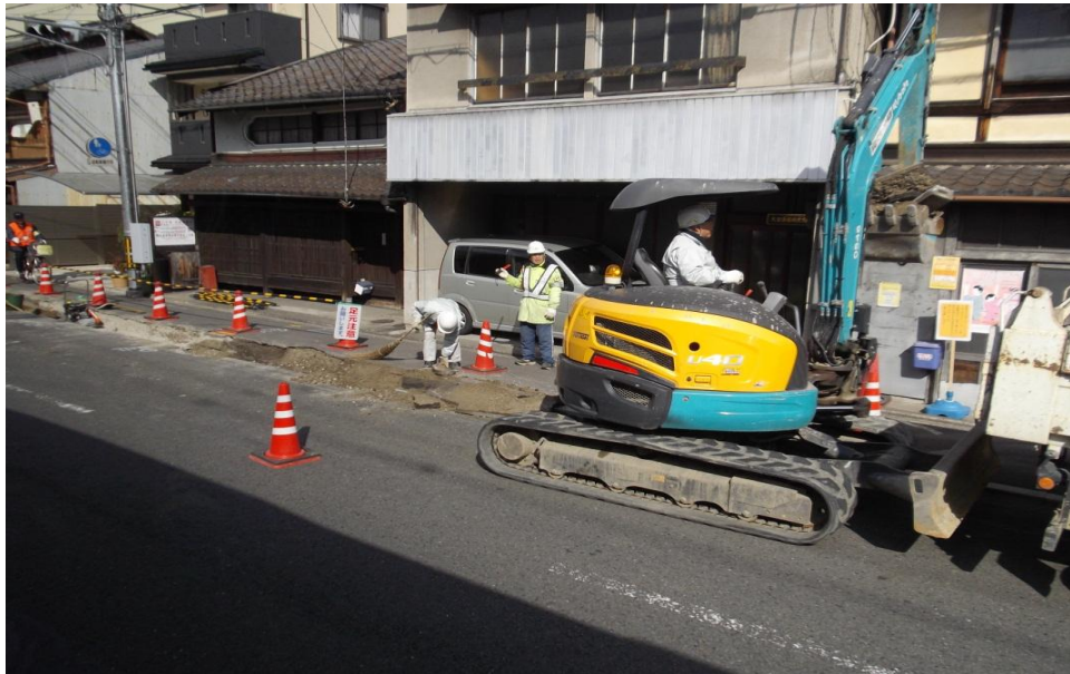
圖二十三、小型道路挖掘工程
