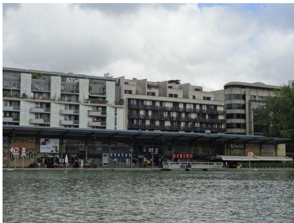
運河左岸的電影院
