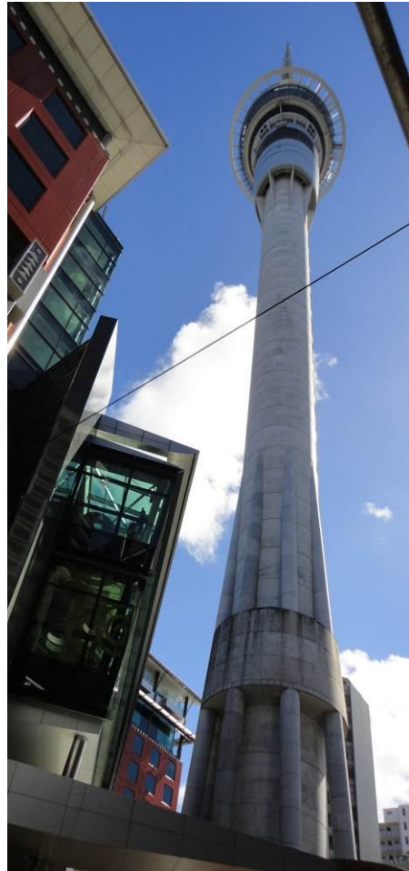
天空塔上之旋轉餐廳及構造形式：RC+SC 複合構造形式
