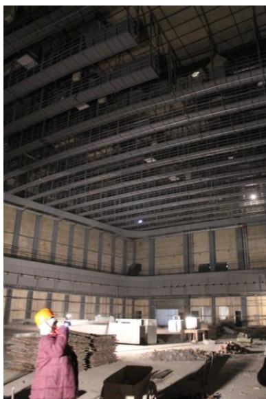
攝影棚（建造中）內部
