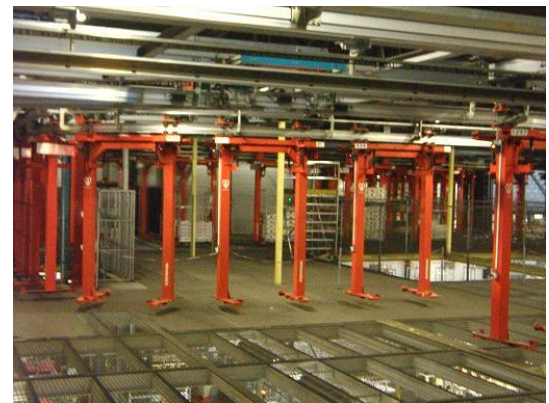
位於天花板的電動貨物輸送帶，全長 15 公里，速度每小時 11 公里，每小時可處理 2600 個花卉架，花卉量相當於 120 臺卡車，可將花卉直送南部客戶
