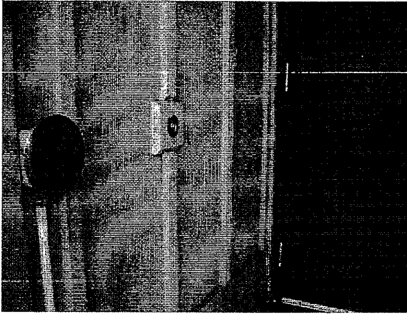
廁所外面的供行動不便者按壓的開門鈕
