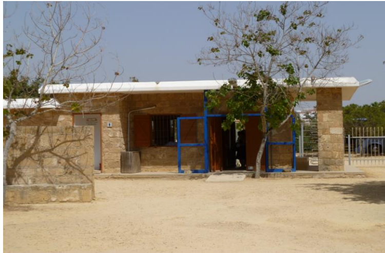
圖 24、國王陵寢遺址出入口管制處
