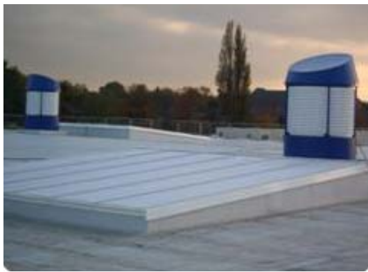
圖三、Ramsey 超市屋頂設置之自動排風系統
