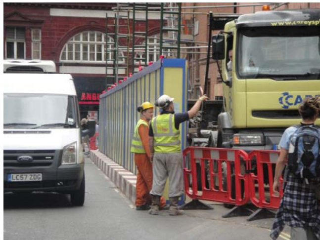
圖一：在狹窄的巷弄，工地仍設置完整之圍籬及防溢座，並保持道路整潔
