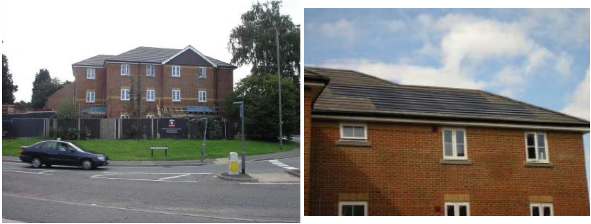
圖二、Brockhill 養護院外觀及屋裝設 PV 板近照
