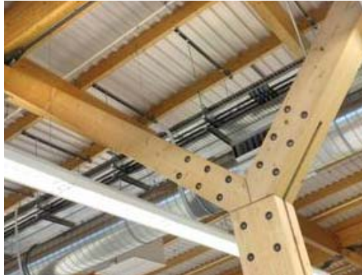
圖五、多用再生木材取代鋼鐵建材
