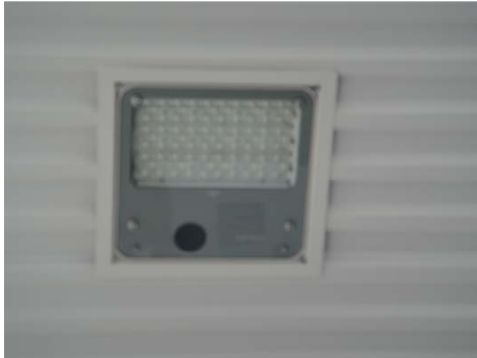
圖十一：加油站自動感應電燈，會隨著光照度自動調節
