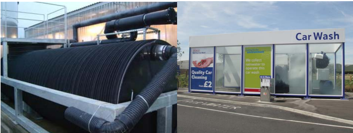
圖七 (左)、雨水收集處理系統；(右)：洗車機之水源為收集雨水用於洗車
