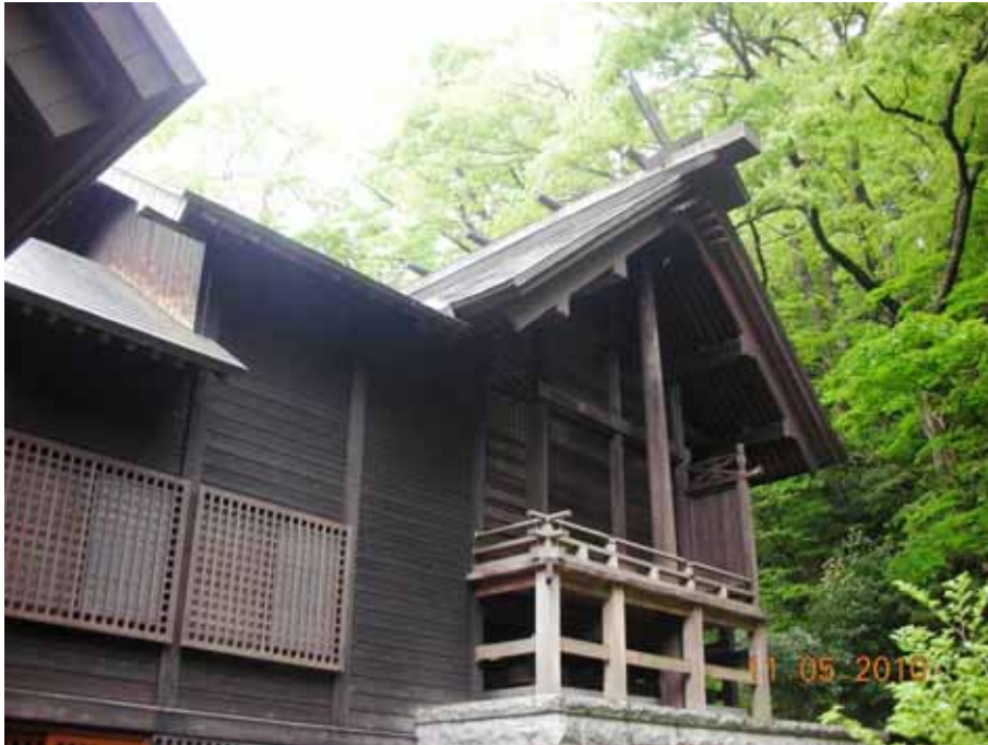
圖五：高田市春日山神社正殿後迴廊連接本殿，屋頂結構為神明造，供奉上杉謙信之牌位
