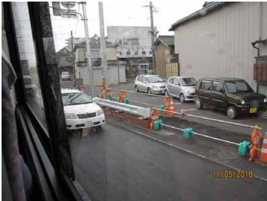
圖四、道路施工圍籬
