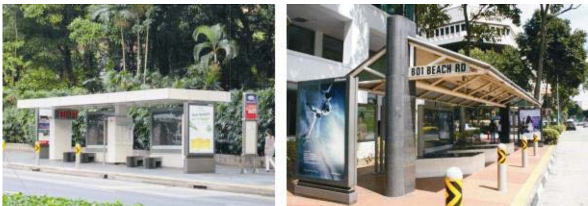
圖 3 新加坡候車亭設施
