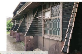
木作扶壁斜撐、外牆雨淋板
