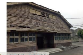
木作扶壁斜撐、外覆雨淋板
