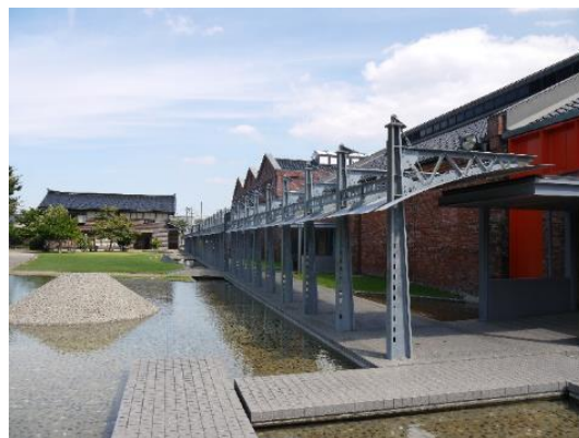
圖 6.1.52 倉庫間連通廊道與水池
