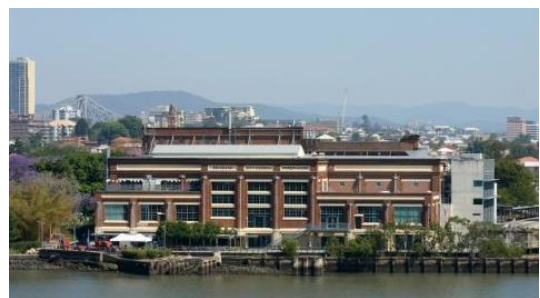
圖 6.1.36 布里斯本發電廠現況外觀
