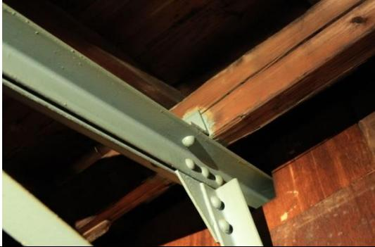
圖 4.2.236 木桁條劈裂
