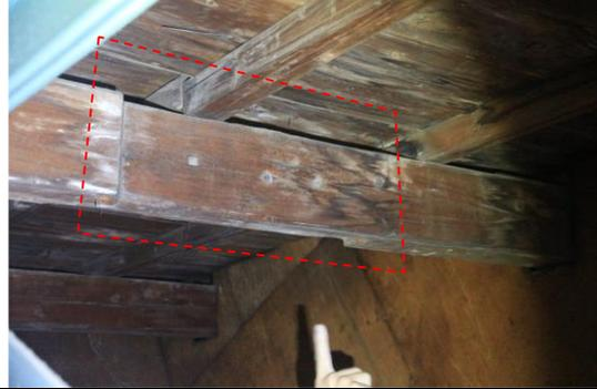
圖 4.2.237 木桁條接榫處上下錯移導致榫木下移
