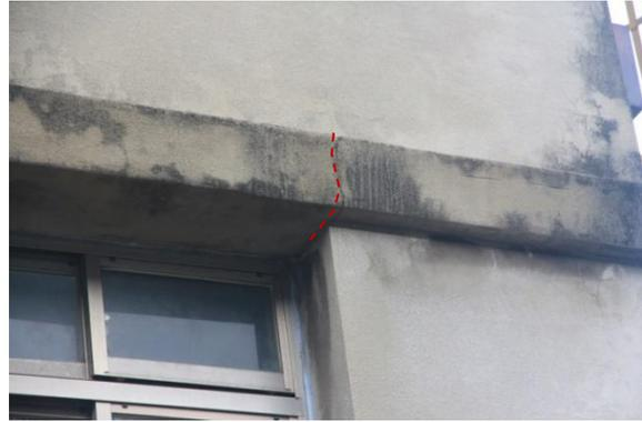
圖 4.2.115 西側立面 RC 楣梁裂縫
