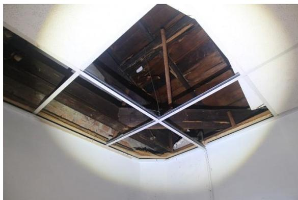
圖 4.2.95 建築角隅處設有火打樑
