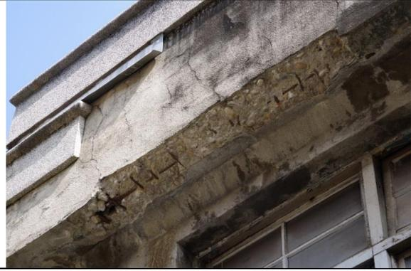
圖 4.2.191 西立面鋼筋鏽蝕混凝土剝落 1
