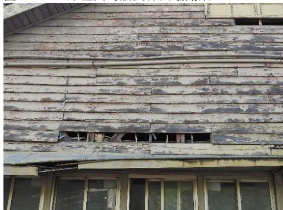
圖 4.3.103 雨淋板破損
