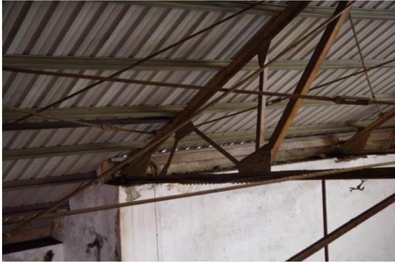
圖 4.2.176 桁架端部現況
