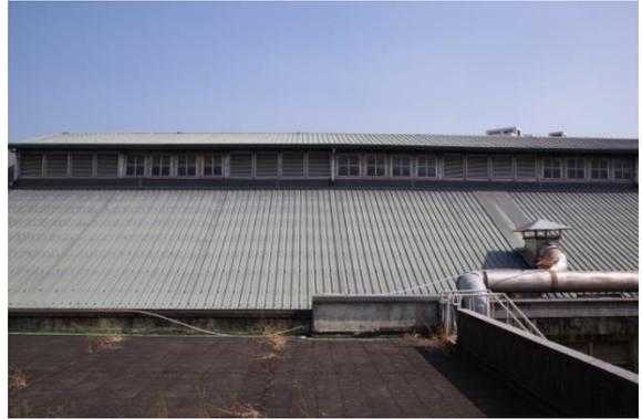
圖 4.2.182 太子樓通風採光窗外觀現況
