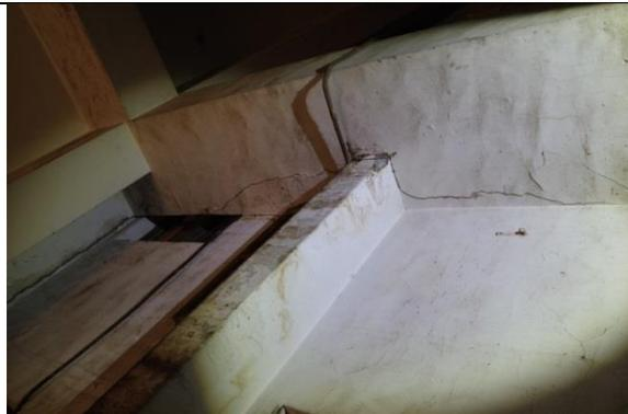
圖 4.2.196 與臨棟建築物相連結處裂縫
