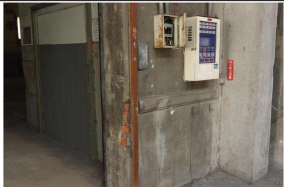
圖 4.2.247 1F 北側入口牆體粉刷層剝落
