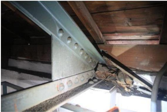
圖 4.2.249 屋架鋼構件以鋼板及鉚釘接合
