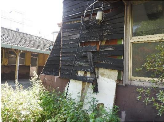
圖 4.3.73 北面東側雨淋板嚴重損毀
