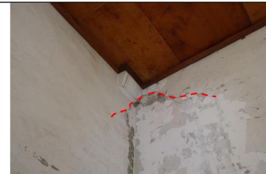
圖 4.2.243 2F 東側山牆斜向裂縫
