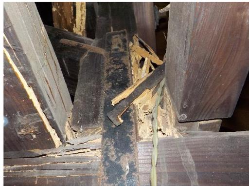
圖 4.3.22 編號 C 架真束遭白蟻蛀蝕毀損
