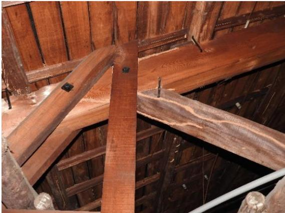
圖 4.3.41 西座編號 3 架表面白蟻遮蔽管延伸
