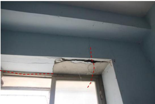
圖 4.2.112 西側入口上方 RC 裂縫
