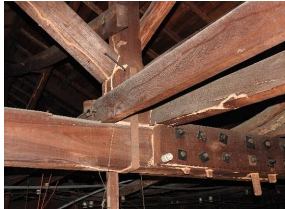
圖 4.3.42 西座編號 3 架表面白蟻遮蔽管延伸
