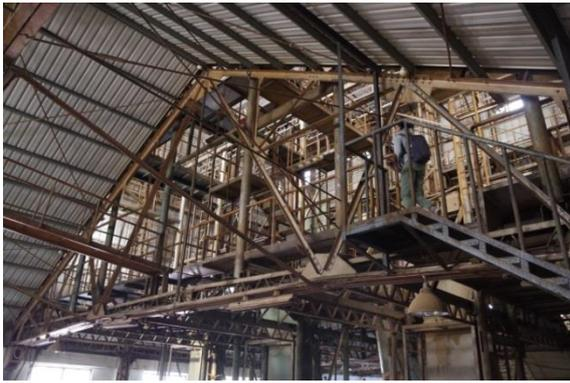
圖 4.2.174 南入口桁架與力霸式鋼架交界現況
