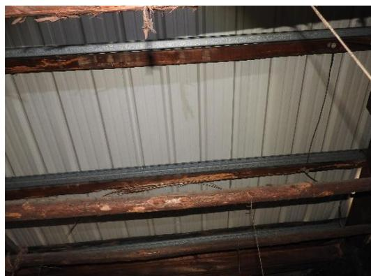
圖 4.3.46 西座編號 6、7 架間母屋增加 C 型鋼支撐
