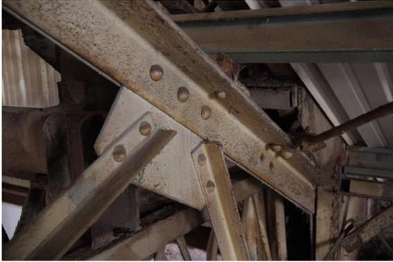
圖 4.2.198 屋架鋼構件以鋼板及鉚釘接合
