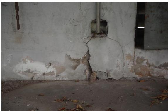
圖 4.2.144 混凝土剝落
