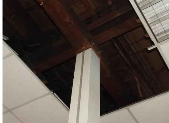
圖 4.3.64 編號 4-B 更換至金屬構件
