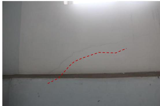
圖 4.2.113 西側梯間牆體斜向裂縫
