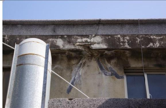
圖 4.2.193 西立面鋼筋鏽蝕混凝土剝落 3
