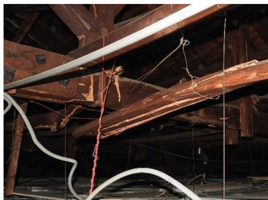
圖 4.3.50 西座編號 4、5 架間樑挾斷裂
