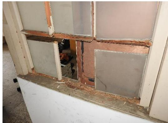
圖 4.3.66 窗扇骨架遭白蟻蛀蝕破壞
