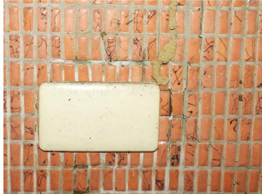
圖 4.3.70 遮蔽管由電器孔延伸
