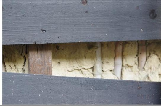
圖 4.2.36 雨淋板損壞
