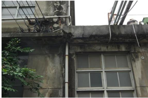
圖 4.2.153 外牆相連部分裂縫
