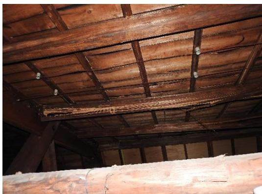
圖 4.3.45 西座編號 2、3 架間母屋遭白蟻危害斷裂
