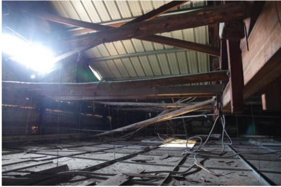
圖 4.2.17 西式正同式木屋架間之筋達(剪刀撐)，交點處含飼木
