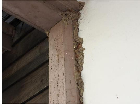
圖 4.3.74 室外柱旁白蟻分飛孔
