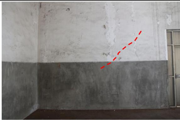
圖 4.2.244 2F 東側山牆-推測因戶外梯雨庇產生斜向裂縫
