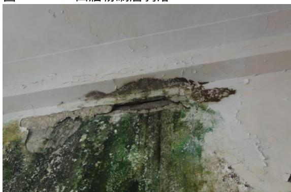
圖 4.2.148 混凝土剝落
