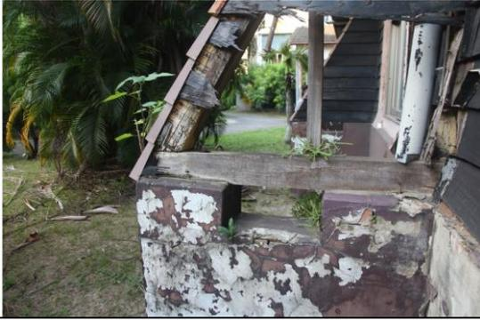
圖 4.2.35 扶壁柱蛀蝕、雨淋板損壞
