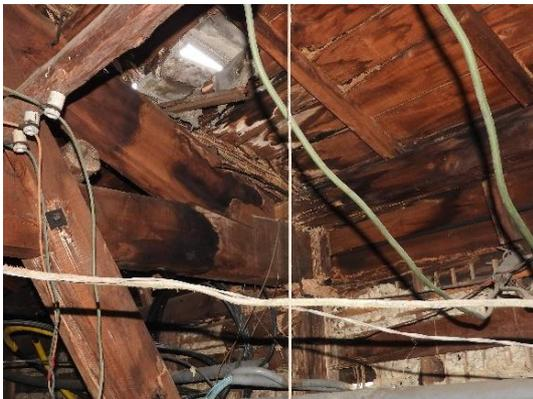
圖 4.3.53 東座編號 2 架漏水及白蟻蟻道
