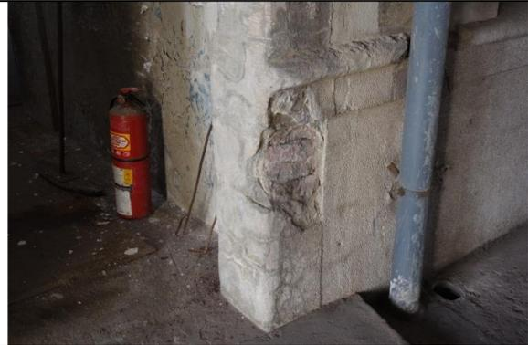
圖 4.2.195 入口牆體粉刷層剝落
