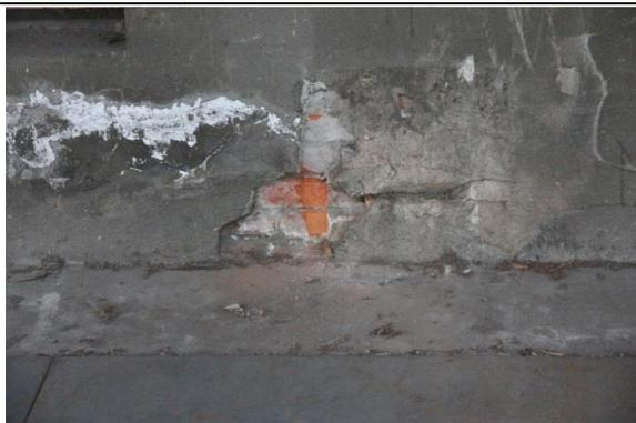
圖 4.2.248 1F 北側牆體粉刷層剝落
