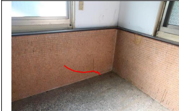
圖 4.2.29 牆壁垂直裂縫(X1, Y1)
