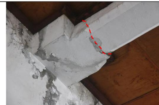
圖 4.2.241 RF 樓板梁端部底裂縫
