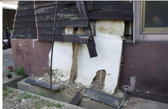
圖 4.2.32 北入口旁編竹牆崩落 2
