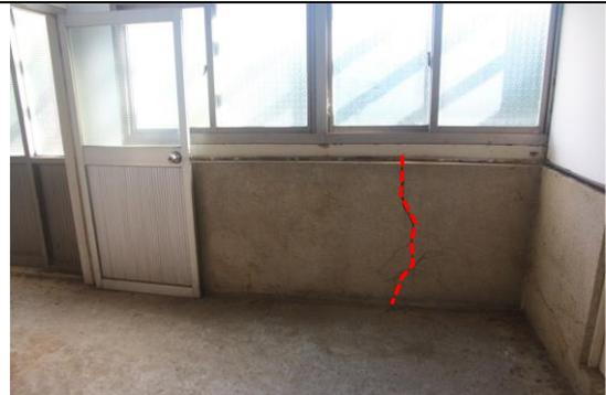
圖 4.2.30 牆壁垂直裂縫(Y8)
