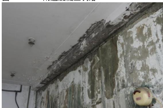
圖 4.2.149 混凝土剝落
