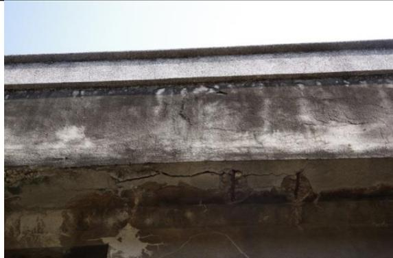
圖 4.2.192 西立面混凝土剝落 2
