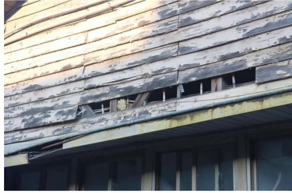
圖 4.2.77 雨林板破損
