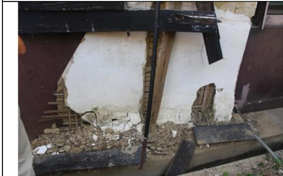
圖 4.2.31 北入口旁編竹牆崩落 1
