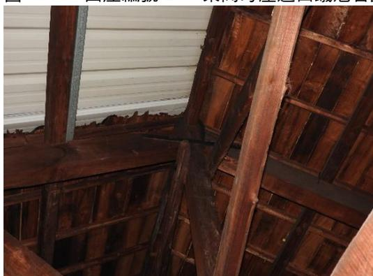
圖 4.3.47 西座編號 6、7 架間更換為金屬浪板
