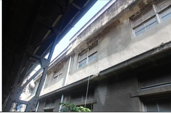
圖 4.2.190 西立面鋼筋鏽蝕混凝土破損
