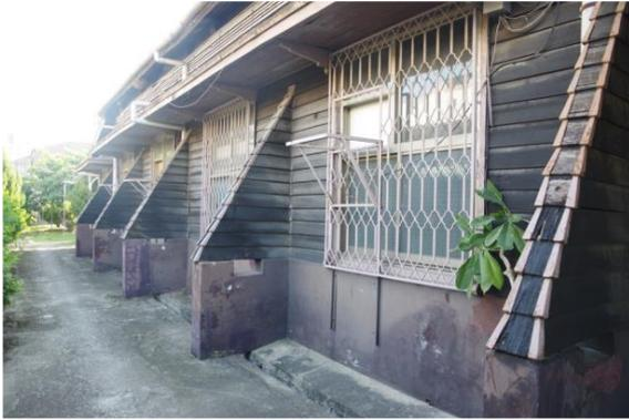
圖 4.2.22 原始扶壁構造 1
