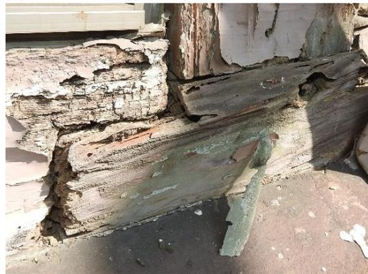
圖 4.3.76 牆面木料褐腐菌腐朽
