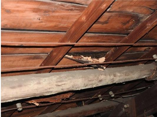
圖 4.3.94 J、K 架間屋面板脫落
