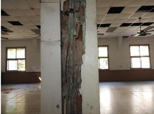
圖 4.3.63 編號 5-B 柱褐腐劣化及白蟻危害
