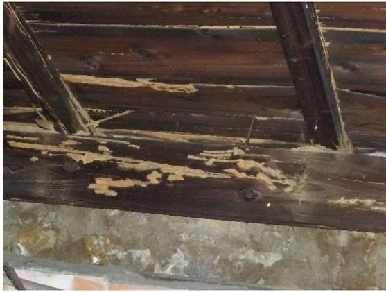
圖 4.3. 27 編號 D、E 架間敷桁發現白蟻分飛孔
