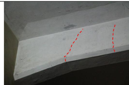
圖 4.2.240 2F 樓板梁端部側裂縫
