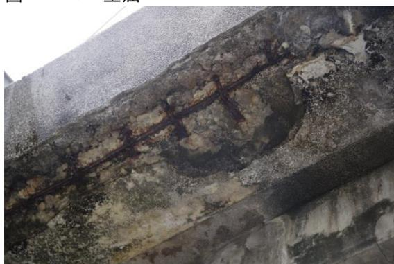
圖 4.2.147 雨遮混凝土剝落
