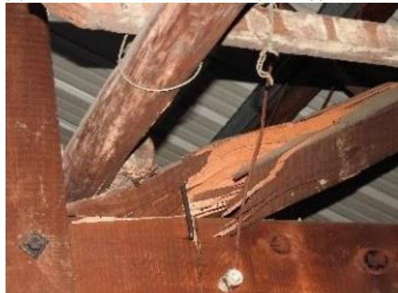
圖 4.3.44 西座編號 6 架方丈遭白蟻蛀蝕導致構件貫穿割裂
