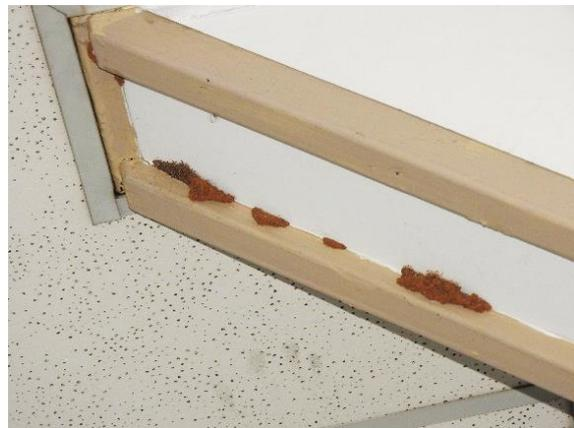
圖 4.3.97 牆面上白蟻分飛孔
