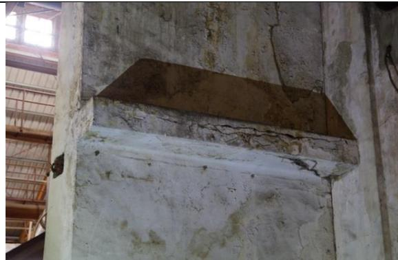
圖 4.2.197 與臨棟建築物相連結處裂縫 2
