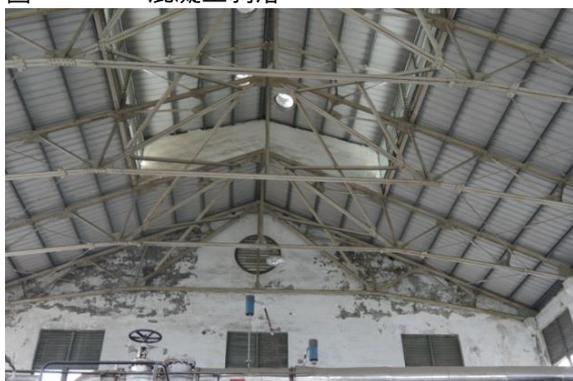
圖 4.2.146 山牆粉刷層剝落
