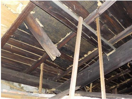
圖 4.3. 29 編號 D、E 架間屋面板掉落
