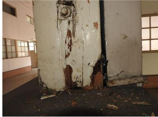
圖 4.3.62 2-B 編號 3-B 柱白腐劣化及白蟻危害
