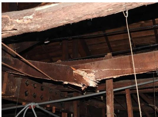
圖 4.3.49 西座編號 3、4 架間樑挾斷裂
