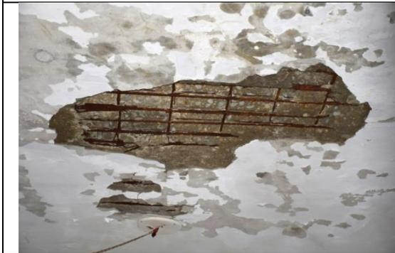
室內天花板混凝土崩落，露出銹蝕之鋼筋。
