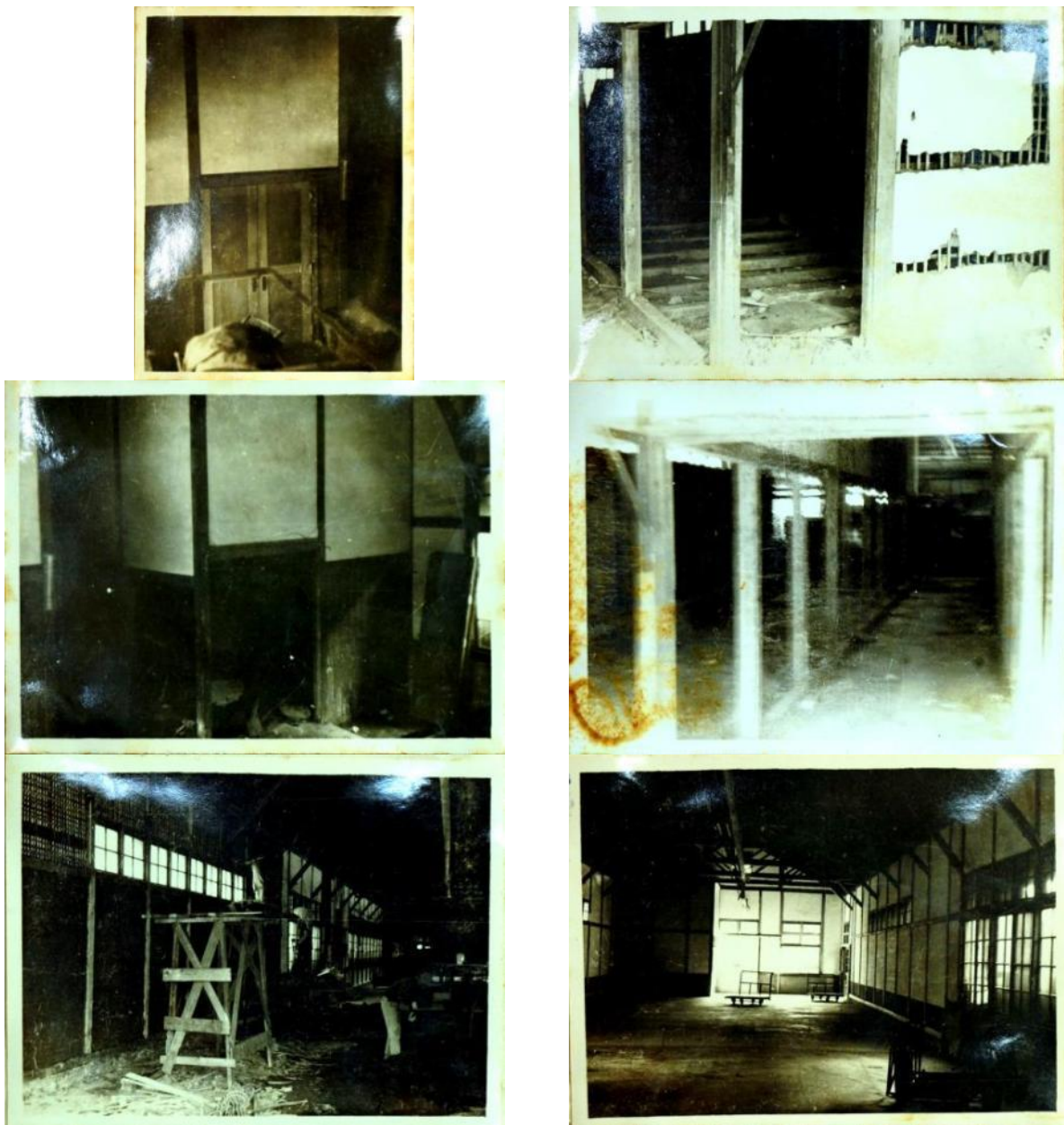
圖 2.4.392 民國 52 年(1963)1 月 23 日臺中菸葉廠呈請臺灣省菸酒公賣局進行乾燥室拆除及修改工程竣工查驗之附件-拆除前照
