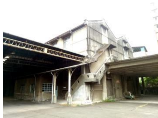
圖 2.4.347 桶菸倉庫(18 建號)現況 資料來源：本計畫拍攝
