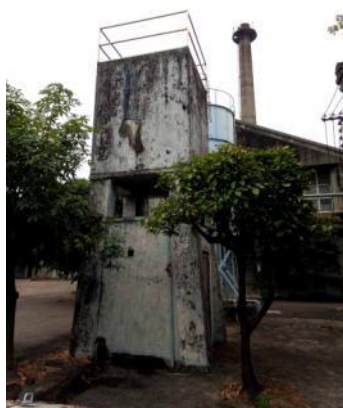
圖 2.4.254 「汽缶室」-水塔(水槽)已被拆除，在原水槽位置旁立有一座鋼筋混凝土製水塔現況
