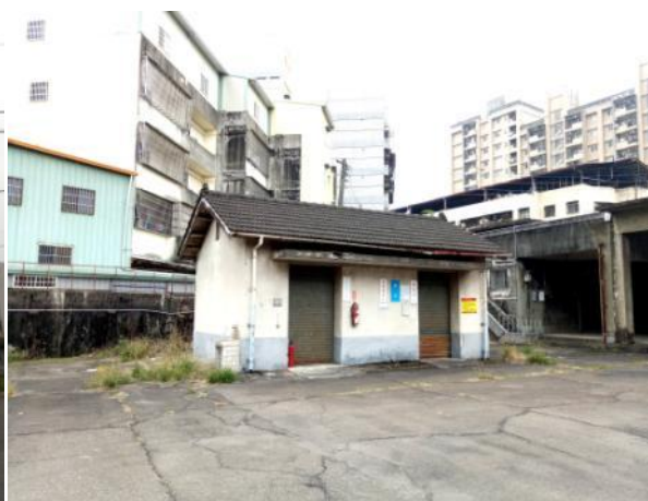
圖 2.4.201 危險品倉庫所在地現況 資料來源：本計畫拍攝
