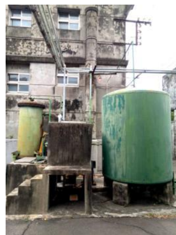
圖 2.4.255 原「汽缶室」的煙突位置改立不同作用的儲存槽數座
