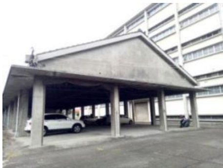
圖 2.4.421 製材工廠現況
