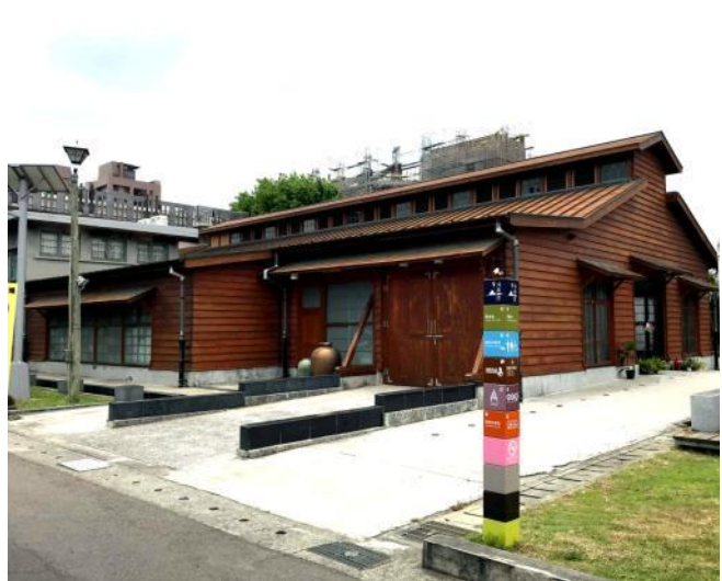
圖 2.4.34 原臺中支局葉煙草再乾燥室現況(現為山時作餐廳；編號：B06)
