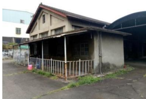
圖 2.4.414 民國 53 年(1964)增建的「材料儲藏室」 現況 資料來源：本計畫拍攝
