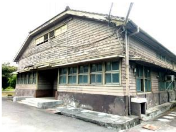
圖 2.4.216 禮堂側門入口現況
