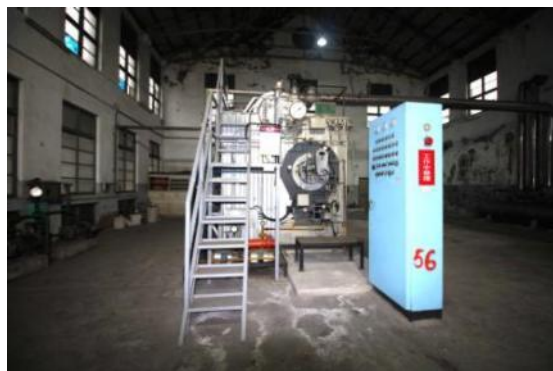
圖 2.4.265 鍋爐室內現存的鍋爐機具現況 資料來源：本計畫拍攝
