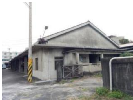
圖 2.4.422 製材工廠現況
