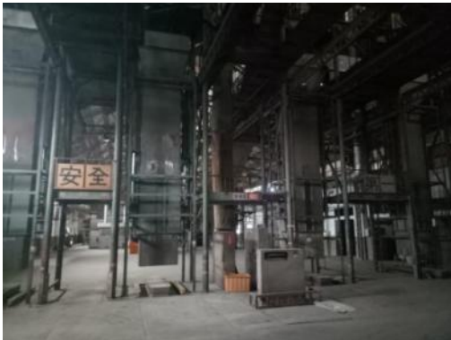
圖 2.4.285 臺中菸葉場複薰室內自動裝桶機現況 資料來源：本計畫拍攝
