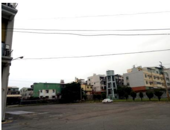
圖 2.4.200 原危險品倉庫所在地現況 資料來源：本計畫拍攝
