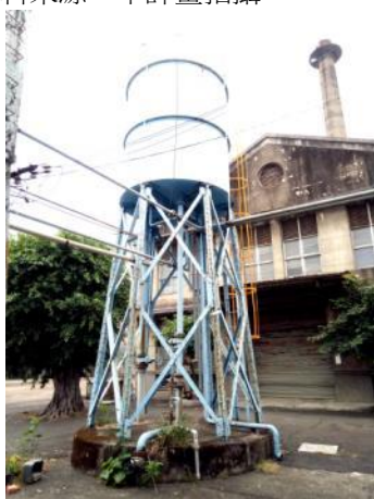
圖 2.4.253 昭和 17 年(1942)所建的「汽缶室」-水塔(水槽)已拆除，原水槽基座上改立現代鐵製水塔
