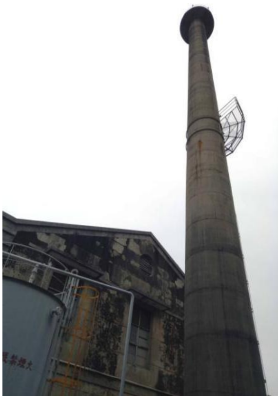
圖 2.4.266 「鍋爐室」後側煙囪的全景現況 資料來源：本計畫拍攝
