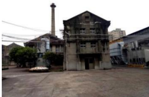
圖 2.4.248 昭和 17 年(1942)12 月竣工的「汽缶室」現況
