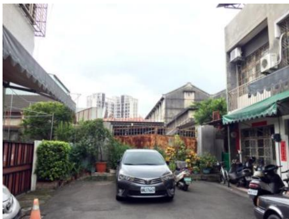
圖 2.4.241 廠區側門與到中興路二段連通道現況 資料來源：本計畫拍攝
