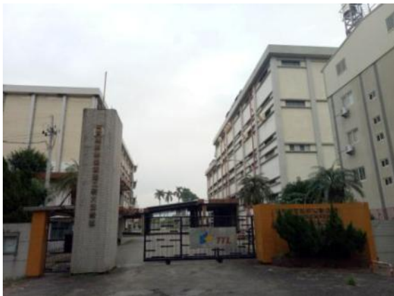
圖 2.4.239 廠區大門現況 資料來源：本計畫拍攝
