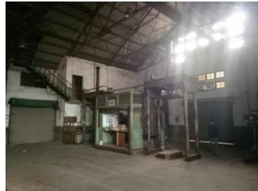
圖 2.4.286 臺中菸葉場複薰室內自動裝桶機控制室現況 資料來源：本計畫拍攝
