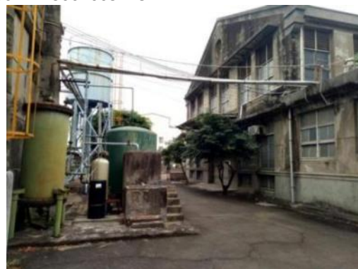
圖 2.4.252 昭和 17 年(1942)12 月竣工的「汽缶室」與民國 46 年(1957)3 月新建的鍋爐室之間的關係
