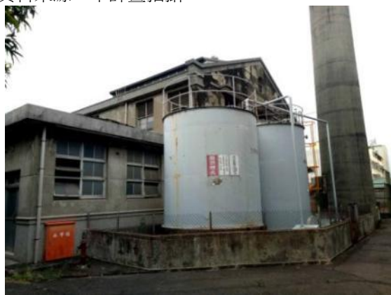
圖 2.4.261 民國 46 年(1957)3 月竣工的「鍋爐室」後側與煙囪的關係
