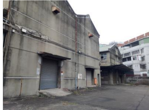
圖 2.4.331 「桶菸倉庫(34 建號)」現況 資料來源：本計畫拍攝
