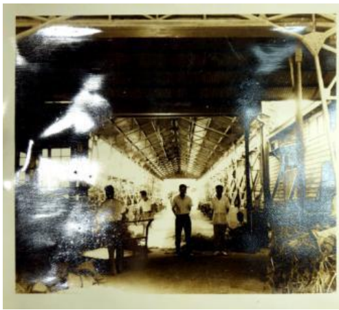
圖 2.4.315 民國 51 年(1962)5 月外銷菸葉檢查場 新建工程竣工照片 資料來源：國家發展委員會檔案管理局 /A307742300K00741931
