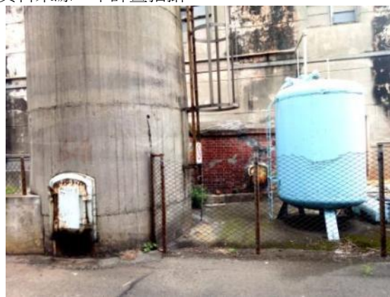
圖 2.4.262 「鍋爐室」後側煙囪的現況
