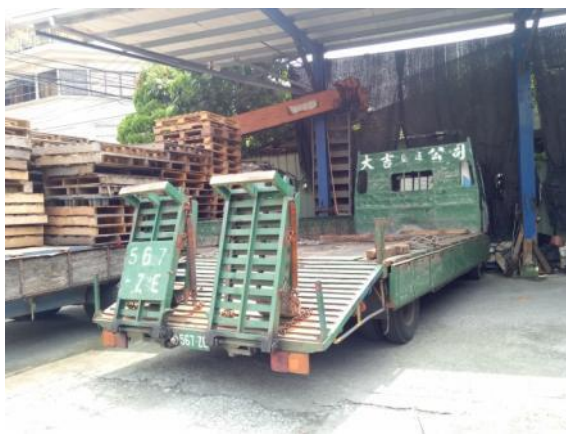
圖 2.3.44 位於吉隆段 807 地號及 809 地號上的老舊廠房-現為大吉交通公司使用中
