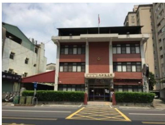
圖 2.3.111 臺中支局葉菸草再乾燥場南端水圳為吉隆段 1410 地號，位於 1411 地號北端與中興路二段銜接，而 1411 地號為臺中市政府警察局霧峰分局內新派出所使用中 資料來源：本計畫拍攝
