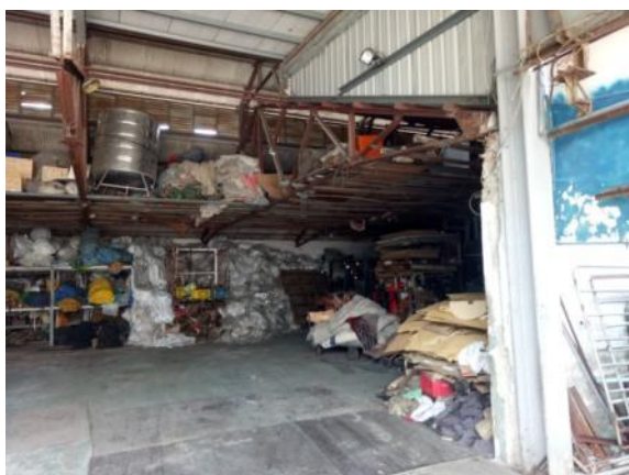
圖 2.3.42 位於吉隆段 807 地號及 809 地號上的老舊廠房內部
